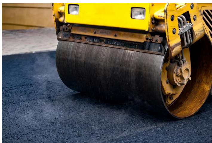
Figura 29 – Ilustração do rolo compactador ideal para revestimentos asfálticos permeáveis.
