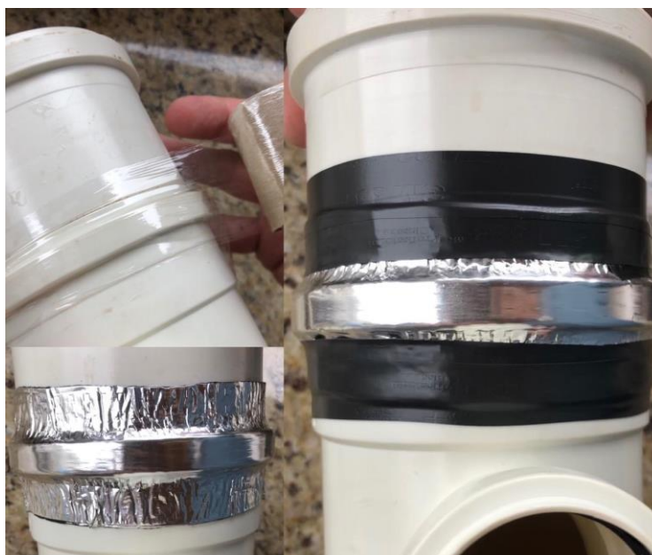
Figura 68 – Procedimento de selagem da junção entre os elementos 2 e 3.
