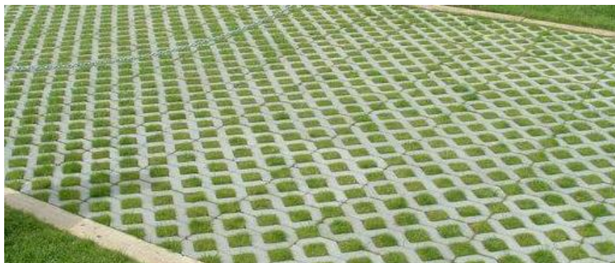
Figura 13 – Blocos vazados de concreto com vazios preenchidos por grama.
