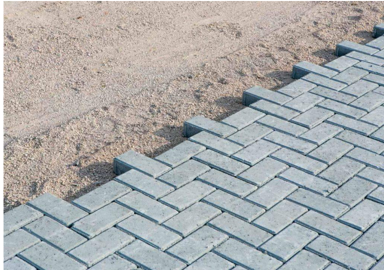
Figura 14 – Blocos intertravados de concreto sobre camada de areia.
