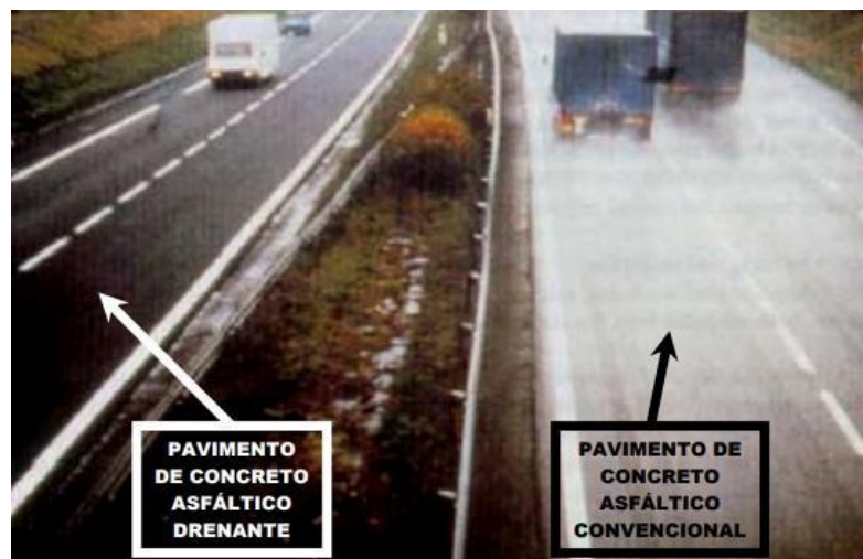
Figura 21 – Redução da formação de névoa pelo efeito de spray d’água em pavimentos revestidos de concreto asfáltico permeável.
