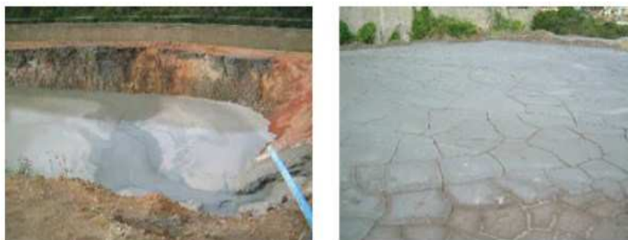
Figura 5 - Lagoa de decantação.
