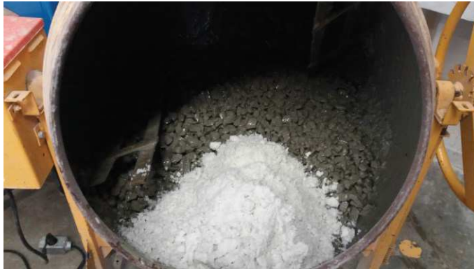
Figura 14 - Materiais sendo adicionados a betoneira.
