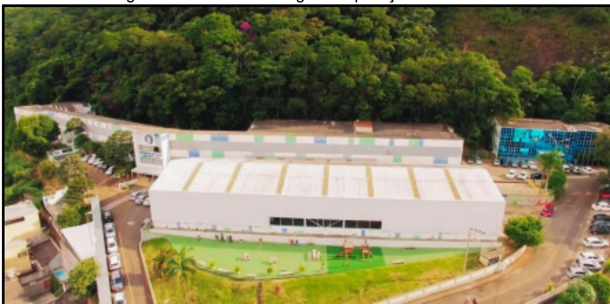
Figura 8: Prédios do Colégio de Aplicação João XXIII/UFJF
