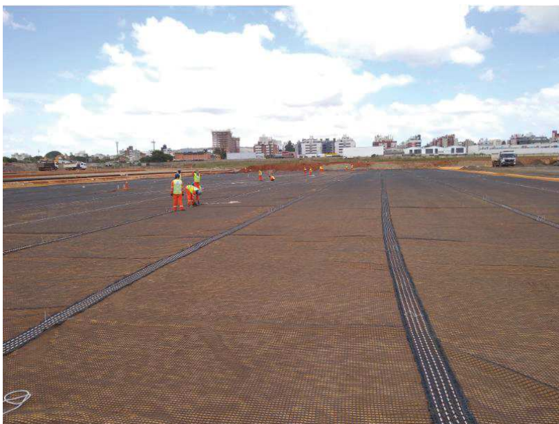
Figura 34 – Instalação da geogrelha.
