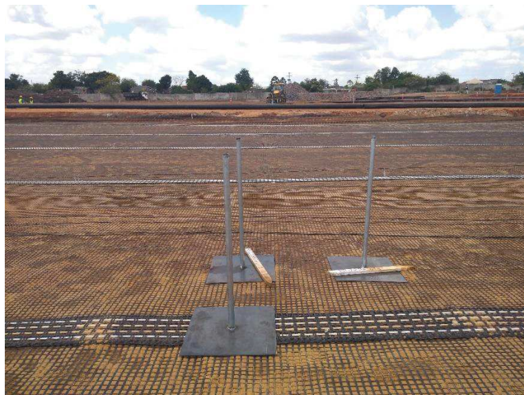
Figura 31 - Instalação das placas de recalque sobre a geogrelha.
