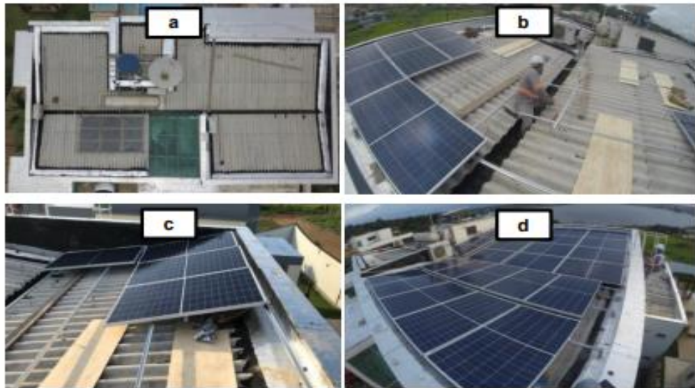
Figura 03 - Instalação dos painéis solares
