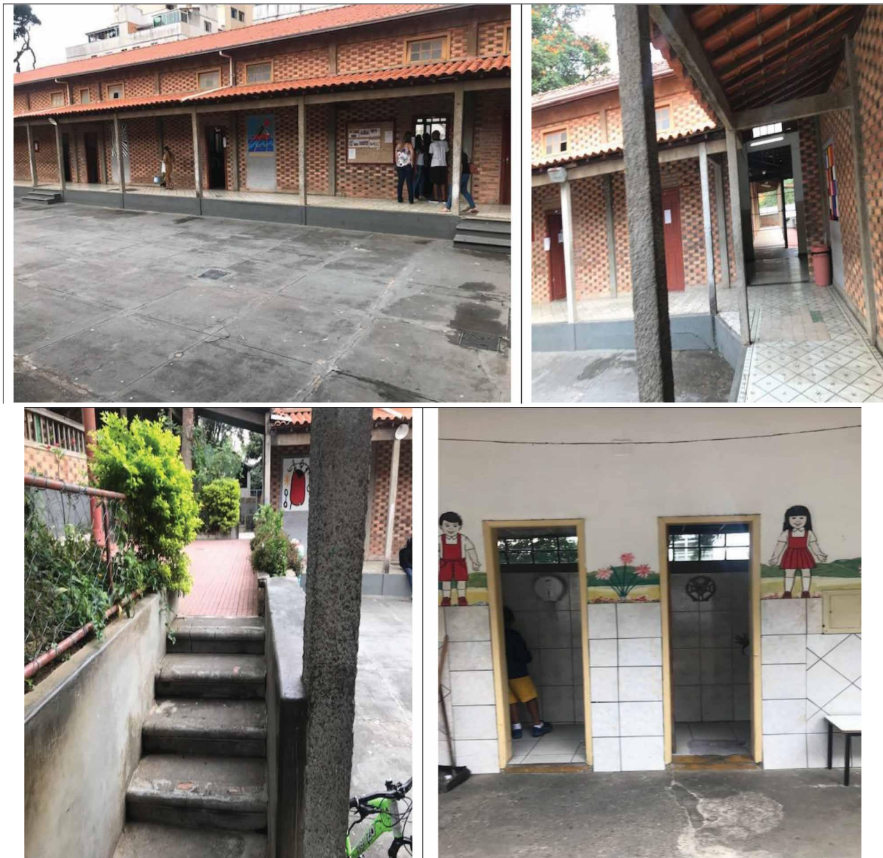
Figura 1 - Fotografias dos espaços físicos e barreiras arquitetônicas de duas escolas públicas
