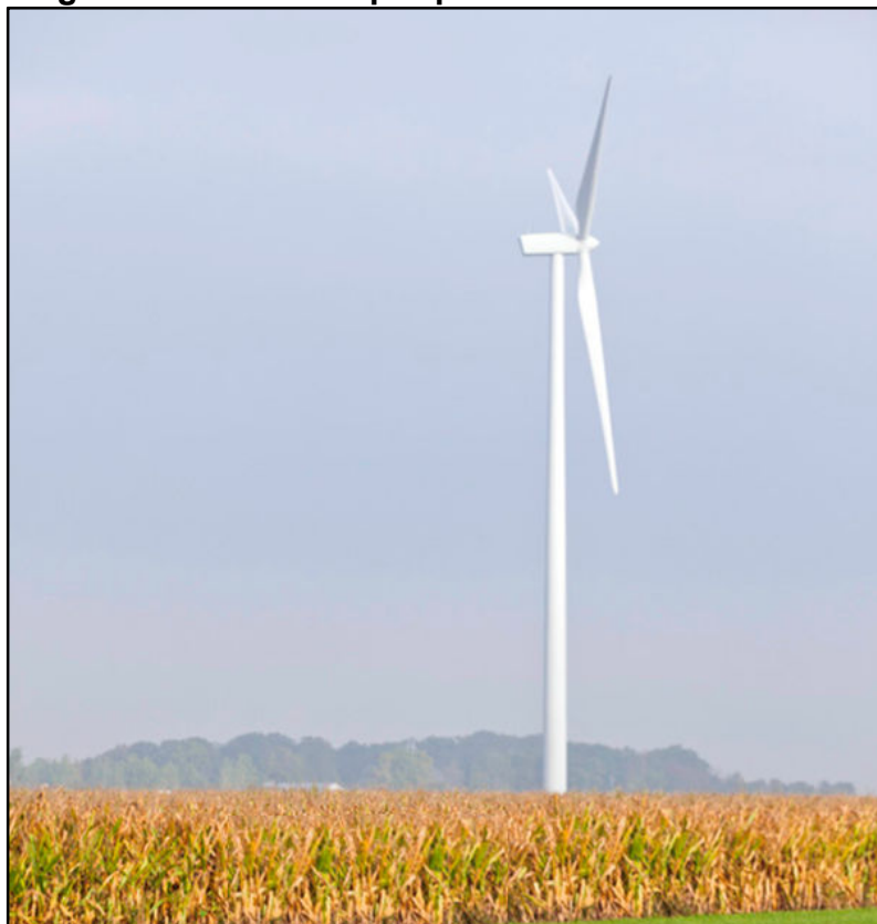
Figura 8: Turbina no parque eólico Blue Creek - OH
