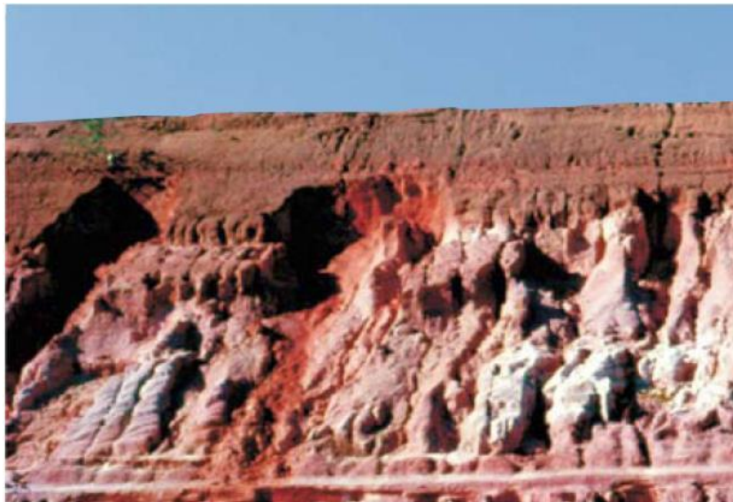
Figura 7- Diferença de comportamento entre solos tropicais presentes em um corte de um talude rodoviário.
