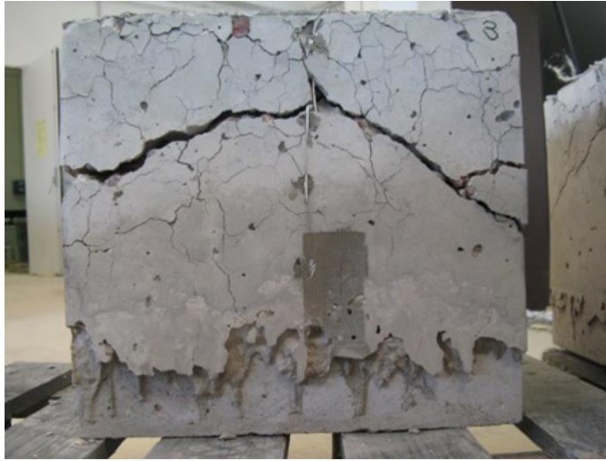
Figura 5 - Efeito de spalling visível.
