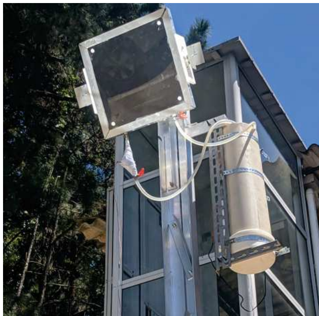
Figura 3.42: Foto da torre com a montagem do receiver B e novo isolamento térmico do reservatório.
