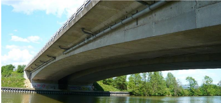
Figura 14 – Ponte PI-57 sobre o rio Oise
