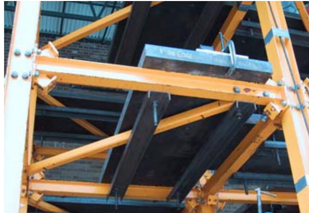
Figura 30 – Detalhe da massa fixada nas vigas
