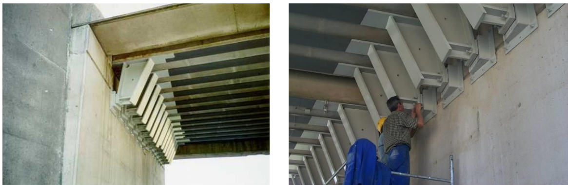
Figura 21 – Detalhe do reforço estrutural
