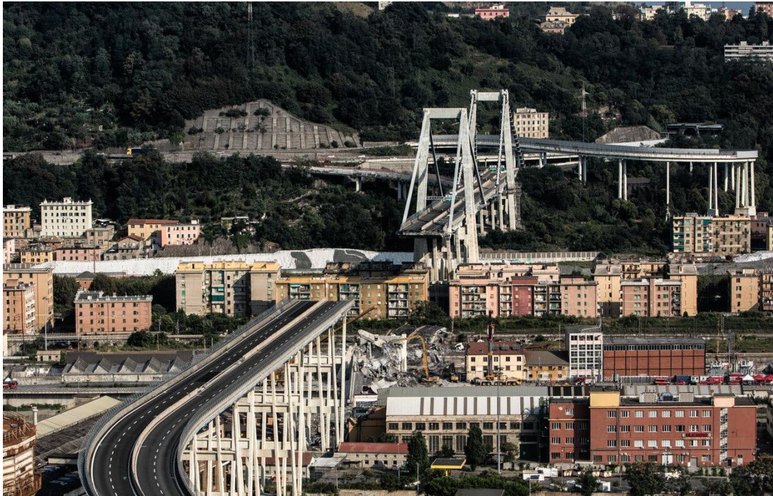
Figura 1 – Colapso da ponte em Gênova, na Itália, em 2018.
