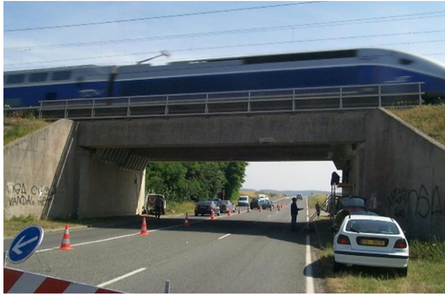
Figura 20 – TGV passando sobre o viaduto
