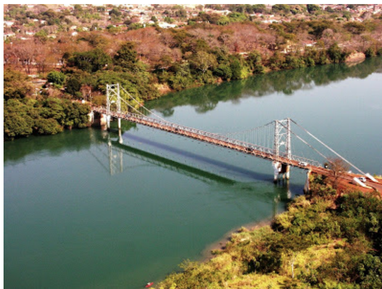
Figura 32 – Ponte Affonso Penna
