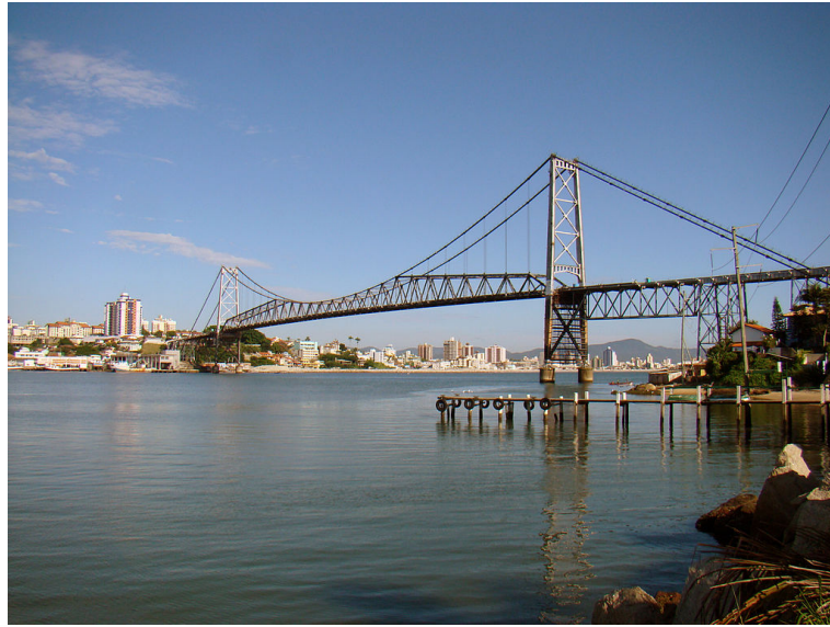
Figura 34 – Ponte Hercílio Luz
