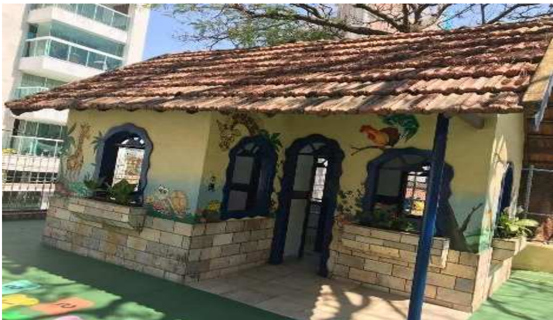
Figura 6 - Visão Frontal da Casinha de Alvenaria
