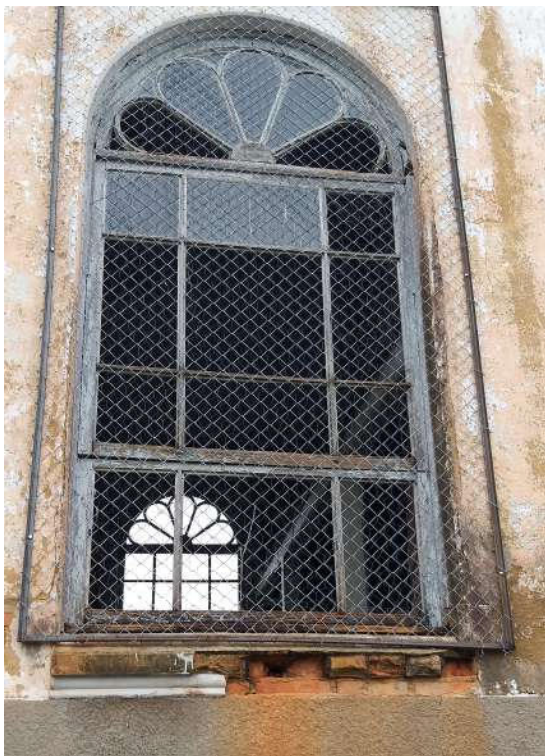
Figura 24: Esquadria de madeira.
