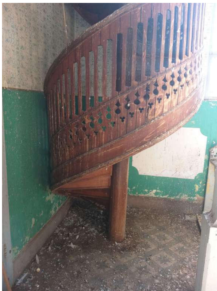
Figura 21: Escada e guardacorpo
