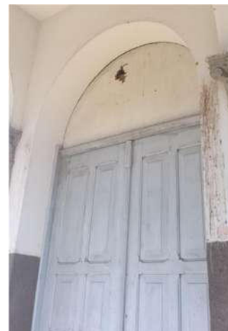
Figura 28: Compensado no local da bandeira da porta.
