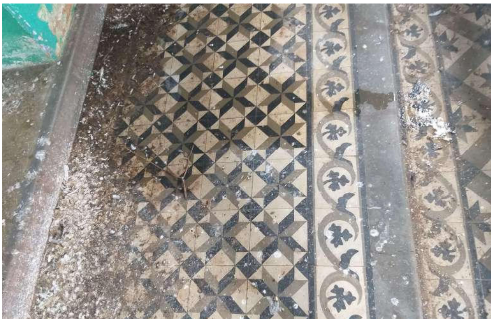
Figura 37: Piso da nave.
