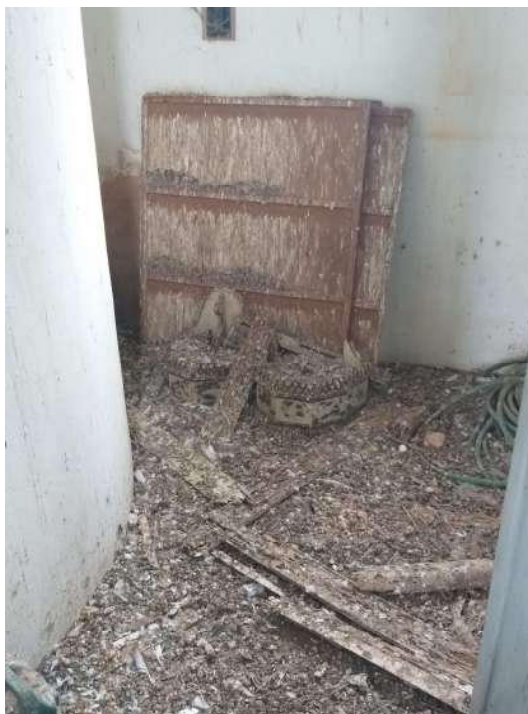
Figura 38: Piso da sacristia.
