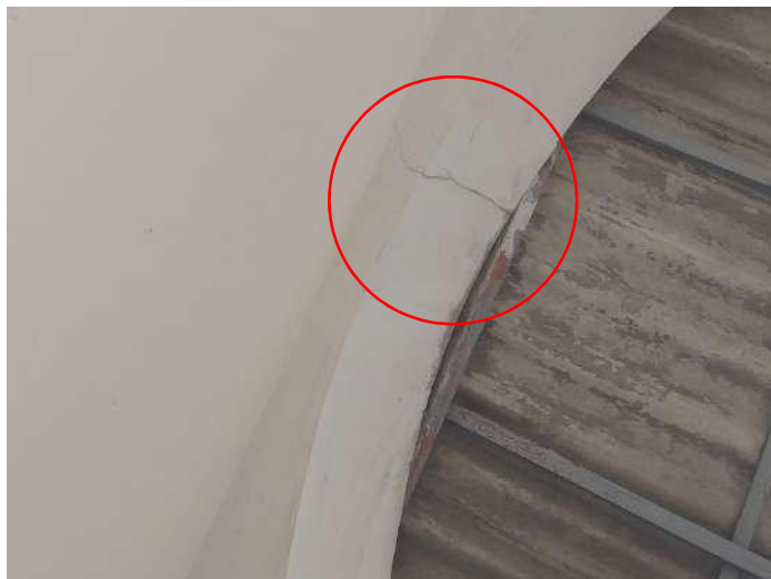
Figura 14: Exposição e corrosão da armadura da laje.
