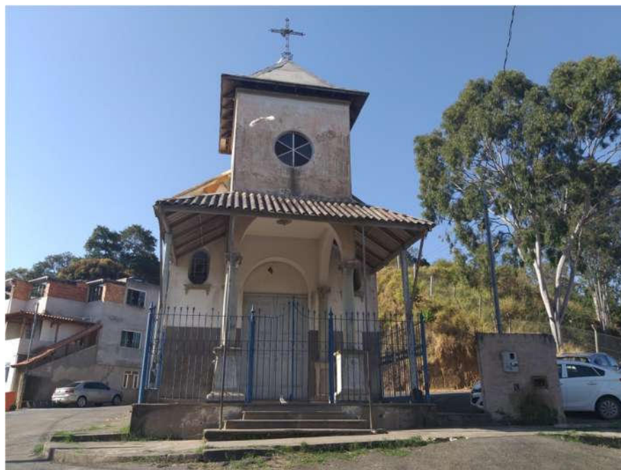
Figura 5: Fachada frontal e entorno da capela atualmente.
