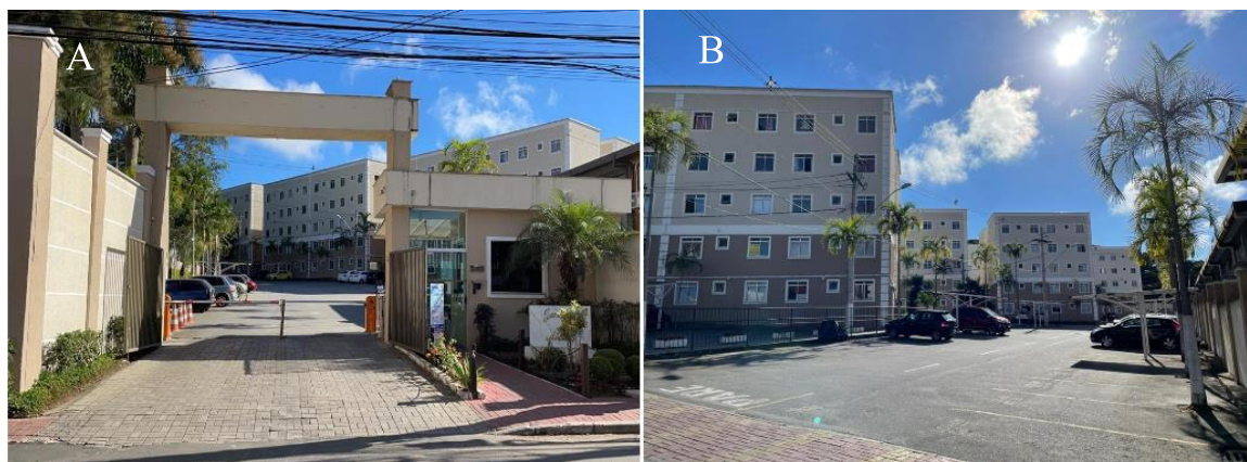
Figura 4- Condomínio Jardim de Minas. A - Fachada e B - Blocos de apartamentos.
