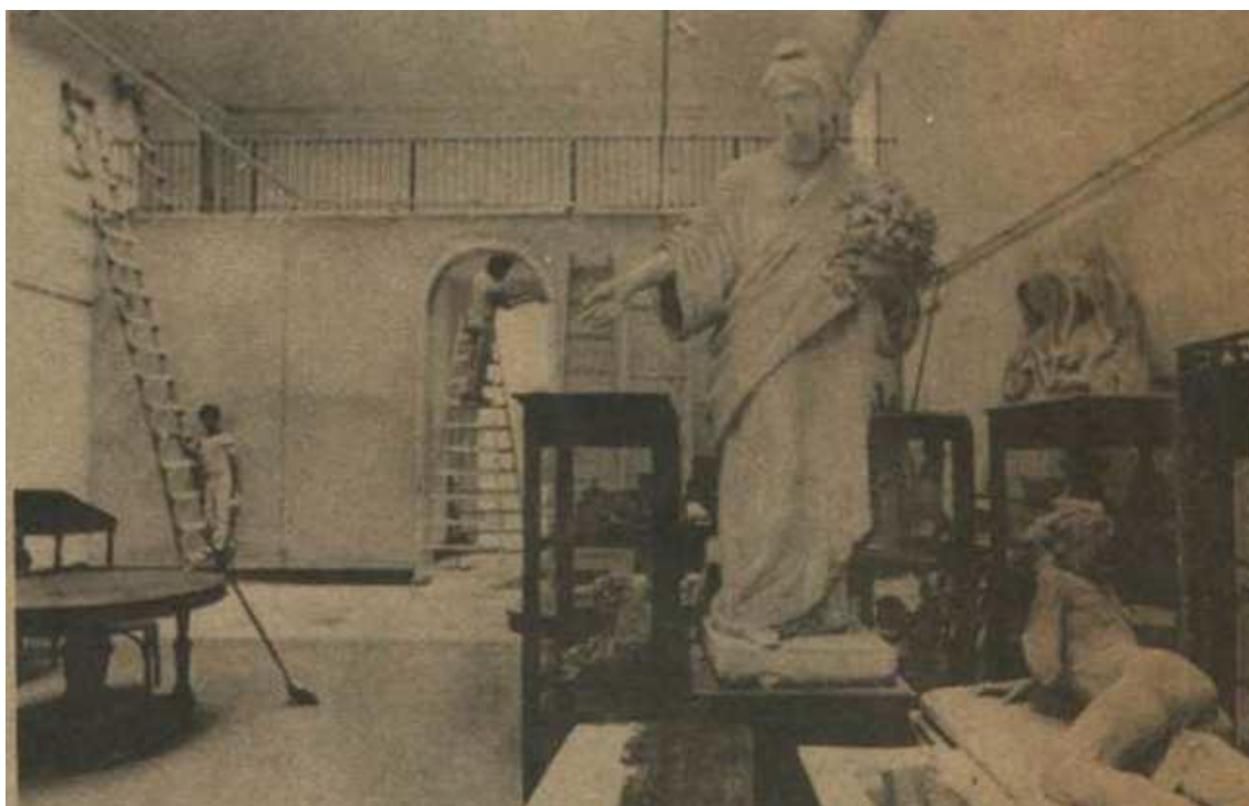
Figura 62. Galeria Maria Amália no período de obras para reabertura (1982). Fonte: O Globo, 31-1-1982
