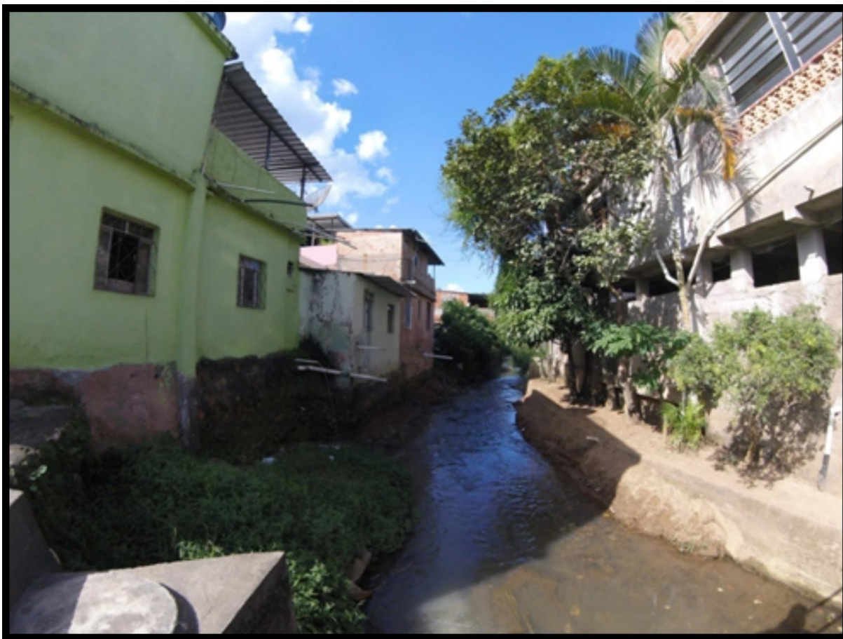
Figura 54- Casas ocupando as margens do córrego Humaitá em área de confluência com a foz da sub-bacia 34 e uma pequena drenagem de 2ª ordem
