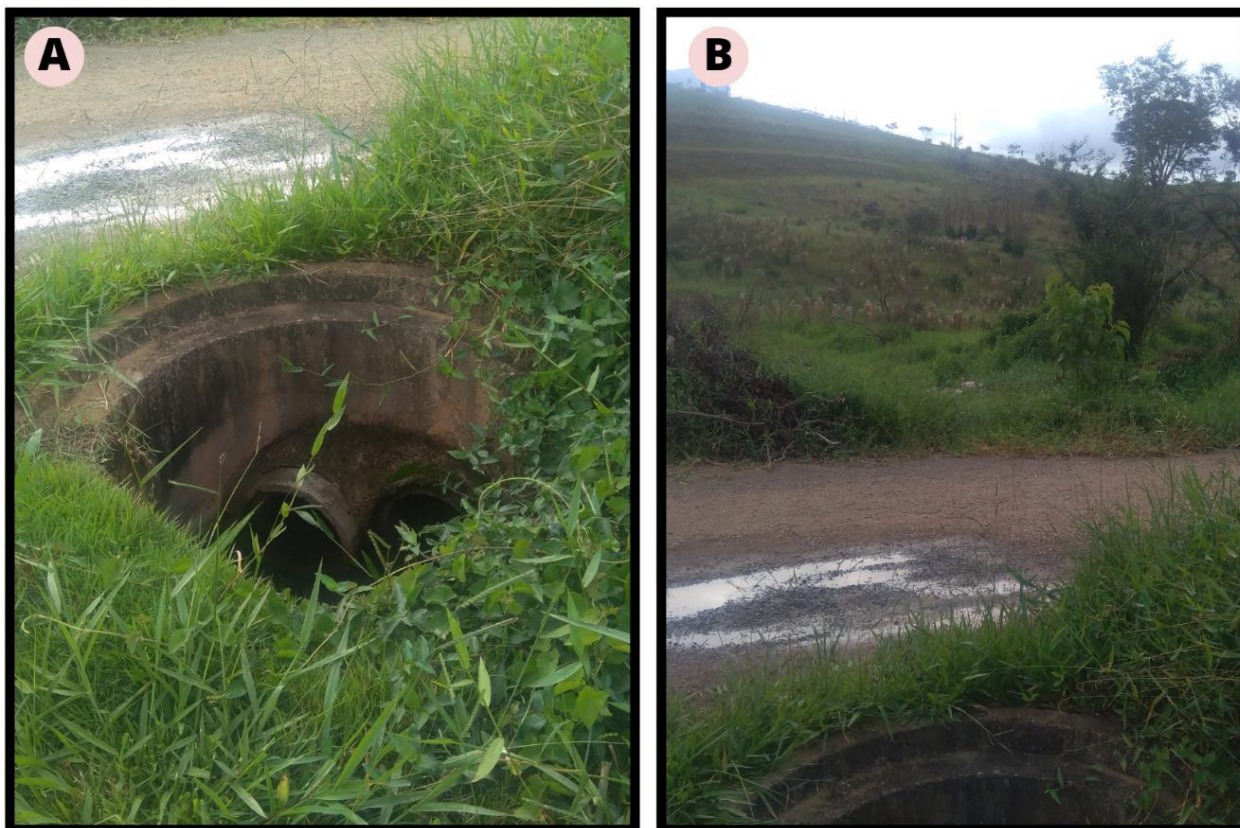
Figura 66 - A- Canalização feita no canal de captura fluvial na rua Cel. Pedro Rachello B- Rua Cel. Pedro Rachello passando por cima da drenagem fluvial.
