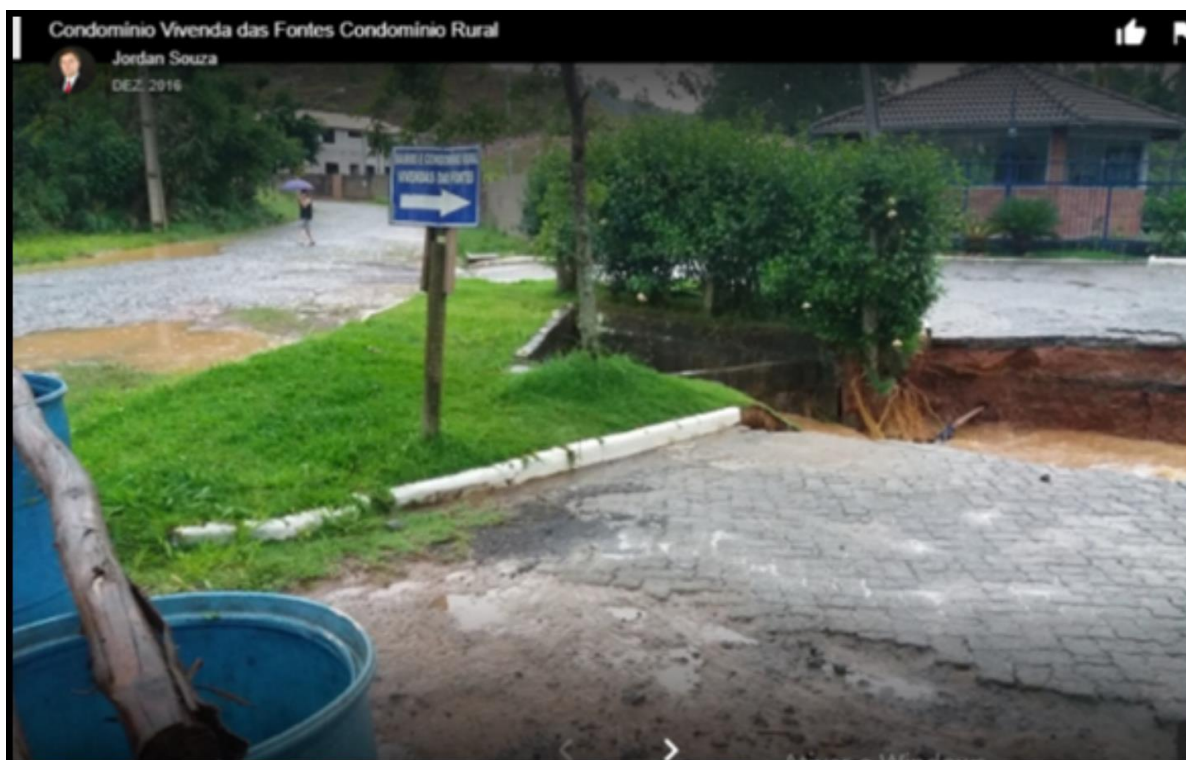
Figura 48 - Destruição da rua pelo aumento de fluxo das águas do rio Humaitá em frente ao Condomínio Vivendas das Fontes.
