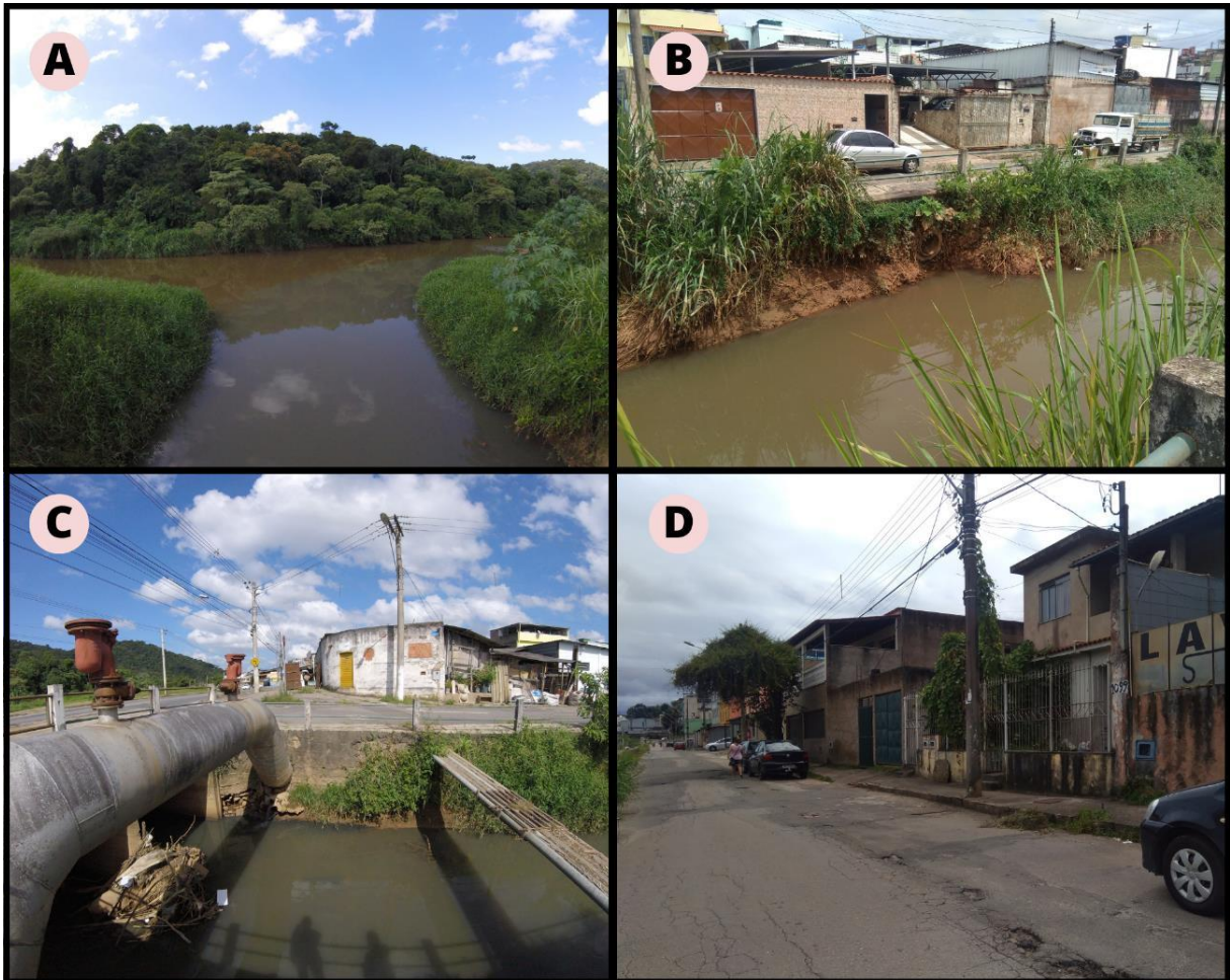
Figura 16 - A- Confluência entre o rio Paraibuna e córrego Humaitá. B- Casas na avenida Lucio Bitencourt e manilhas fluviais. C- Tubos de água e construções. D- Casas na Av. Lucio Bitencourt no bairro Industrial.
