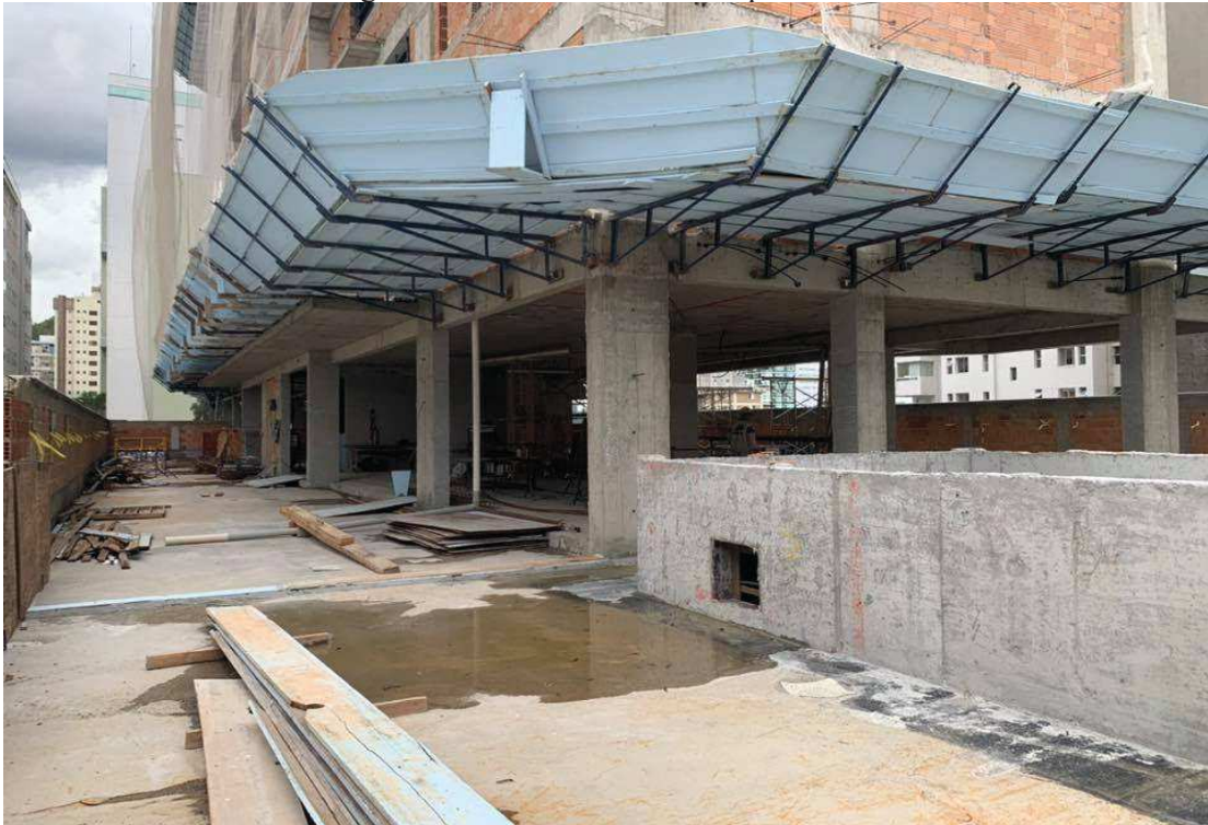
Figura 2 - Canteiro de obra do tipo restrito
