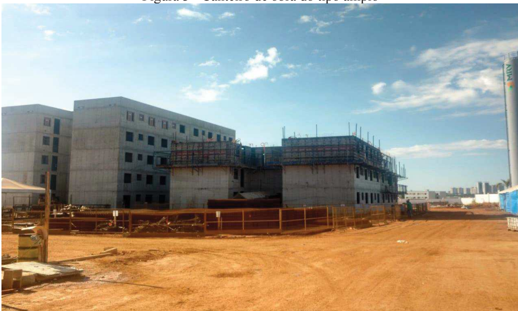
Figura 3 - Canteiro de obra do tipo amplo
