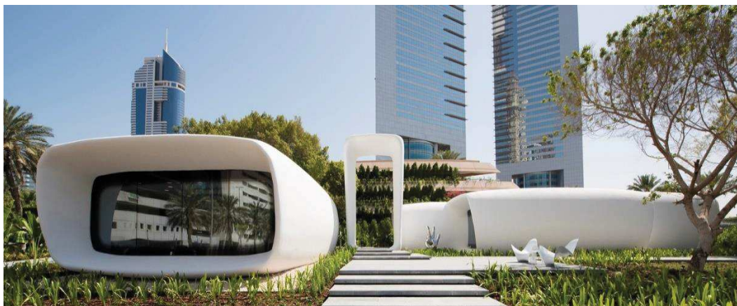
Figura 24- Edifício de escritórios em impressão 3D
