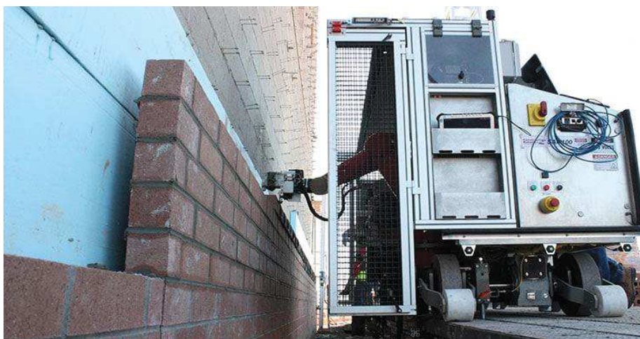
Figura 22- Robô de assentamento de argamassa
