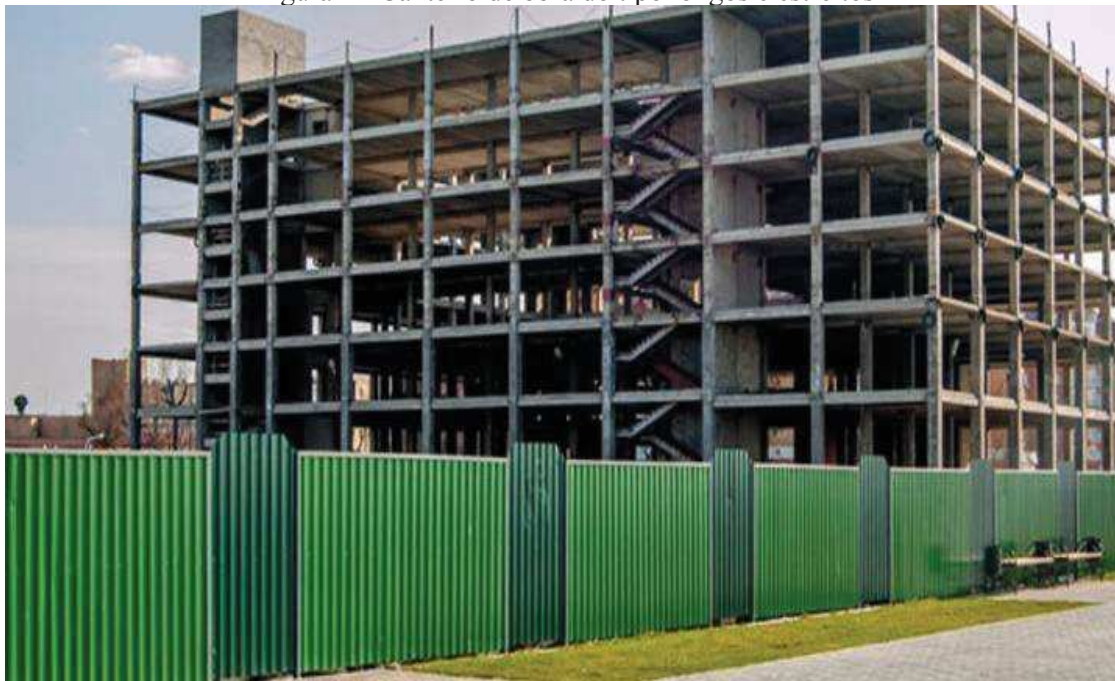
Figura 4 - Canteiro de obra do tipo longos e estreitos
