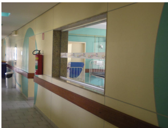
Figura 96 – Detalhe dos painéis de vidro – visores (fonte: a autora).
