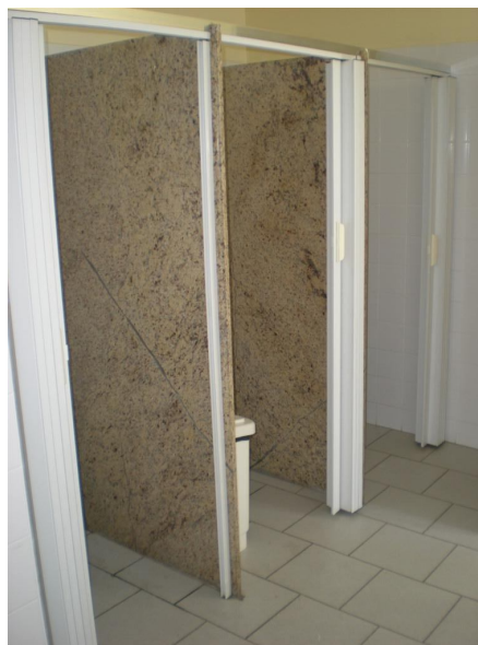
Figura 102 – Divisória dos banheiros das enfermarias (fonte: a autora).
