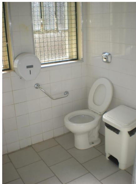
Figura 100 – Detalhe do sanitário e das barras de apoio (fonte: a autora).
