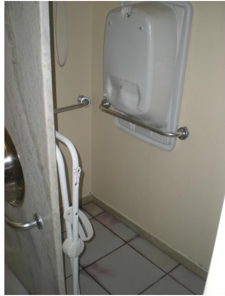
Figura 30 – Detalhe da divisória do chuveiro no banheiro da enfermaria (Fonte: a autora).
