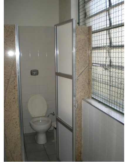
Figura 104 – Detalhe do banheiro de acompanhantes feminino (fonte: a autora).
