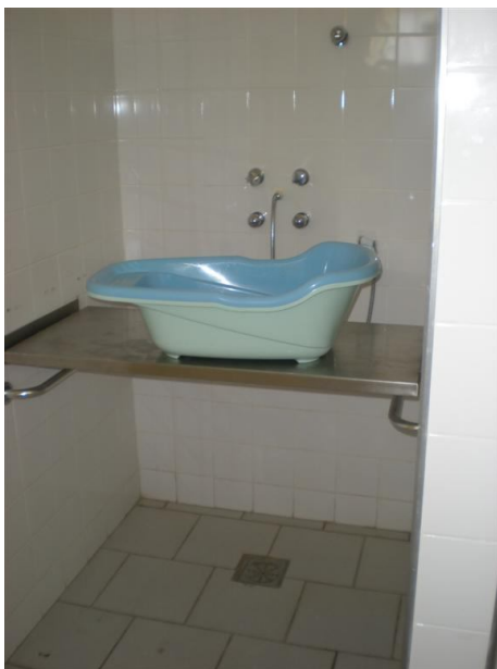
Figura 101 – Chuveiro com suporte para banheira (fonte: a autora).
