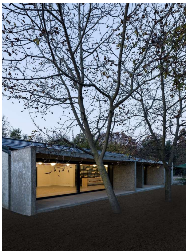
Figura 08 – Pórticos na Fachada Sul.
