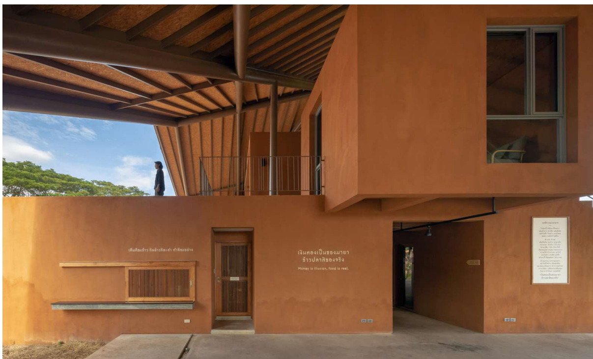
Figura 22 – Tonalidade das Paredes, por Ketsiree Wongwan.
