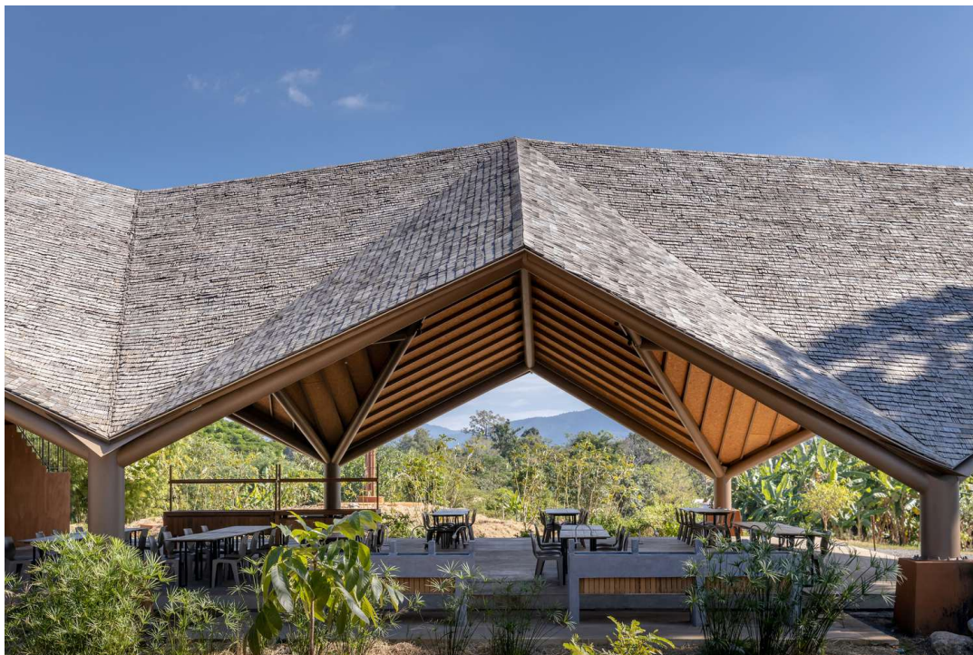
Figura 19 – Telhado feito com bambu local, por Ketsiree Wongwan.
