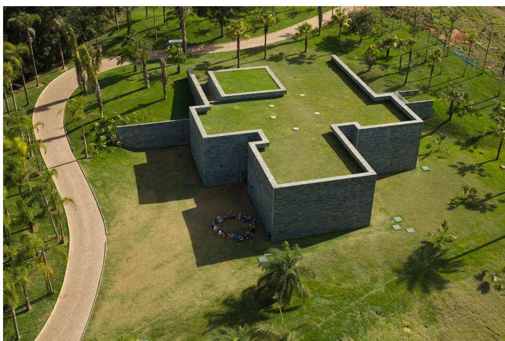
Imagem 18: Vista aérea mostrando as paredes de pedra e o telhado gramado da Cosmococa
