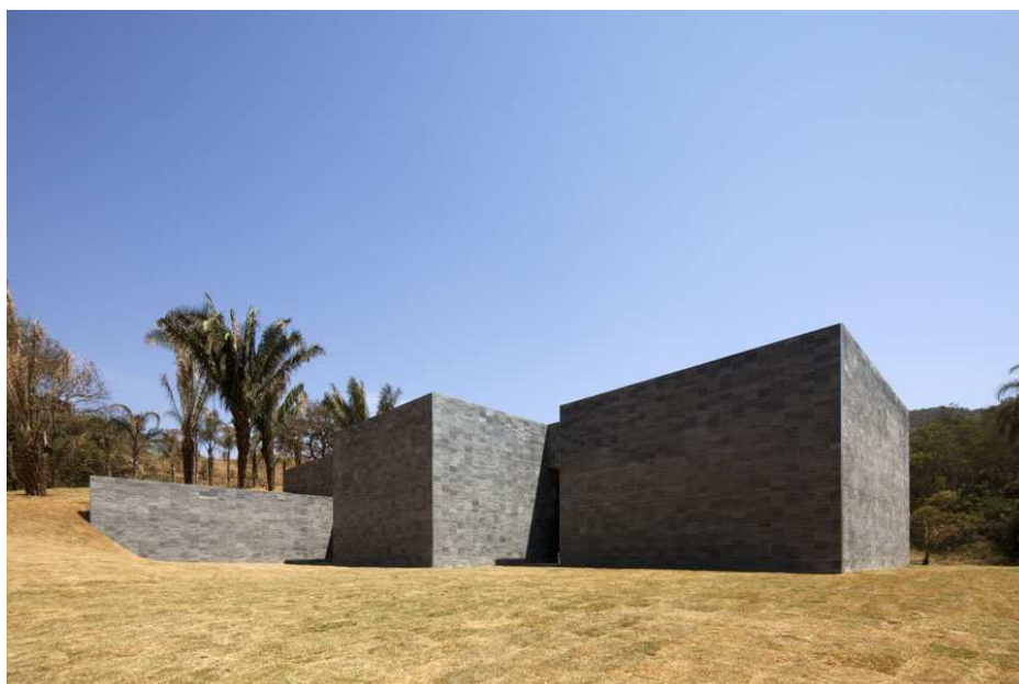
Imagem 13: Fachadas de pedra
