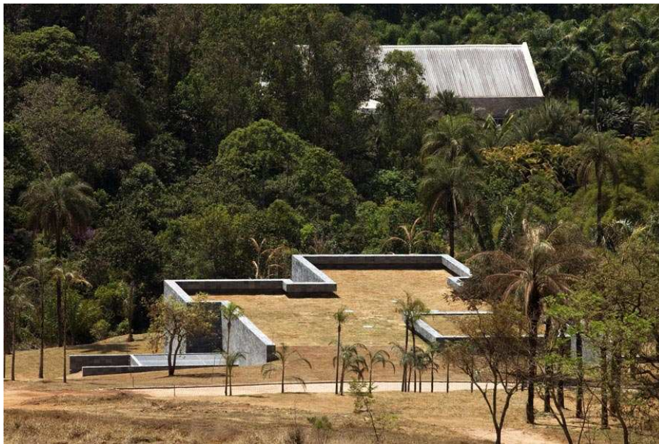
Imagem 11: Telhado da galeria em conexão com o terreno
