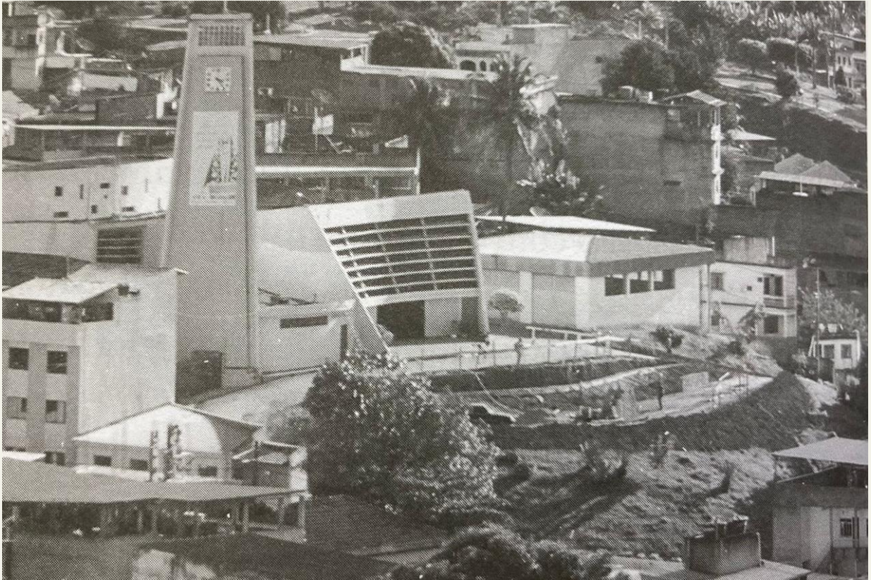
Figura 24: Construção do estacionamento (2009)
