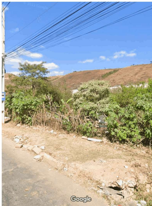
Figura 8 – Deterioração das calçadas
