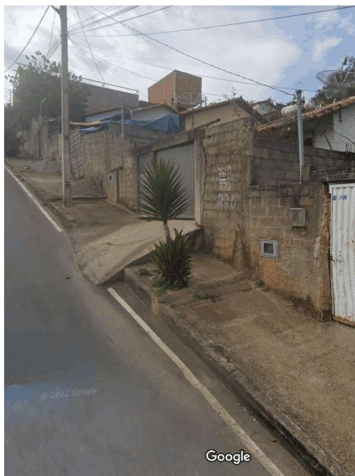
Figura 6 – Obstruções na calçada
