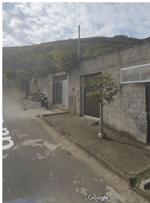
Figura 7 – Obstruções na calçada
