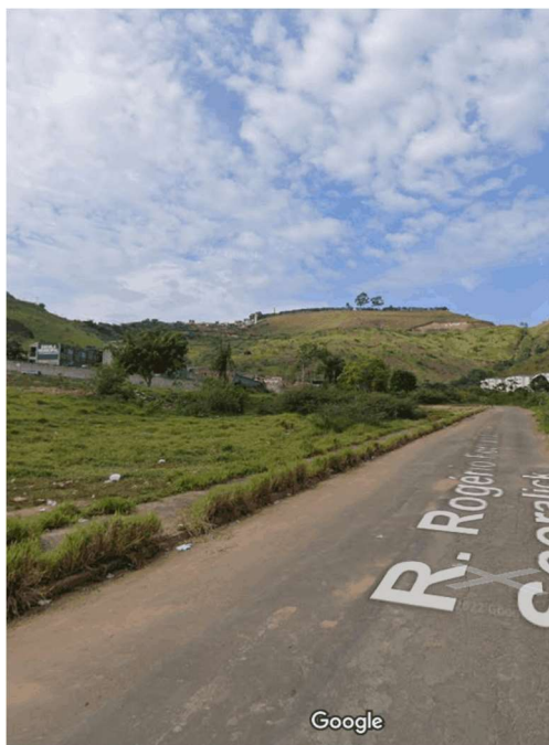
Figura 11 – Trecho do empreendimento não abarcado pela rede de iluminação
