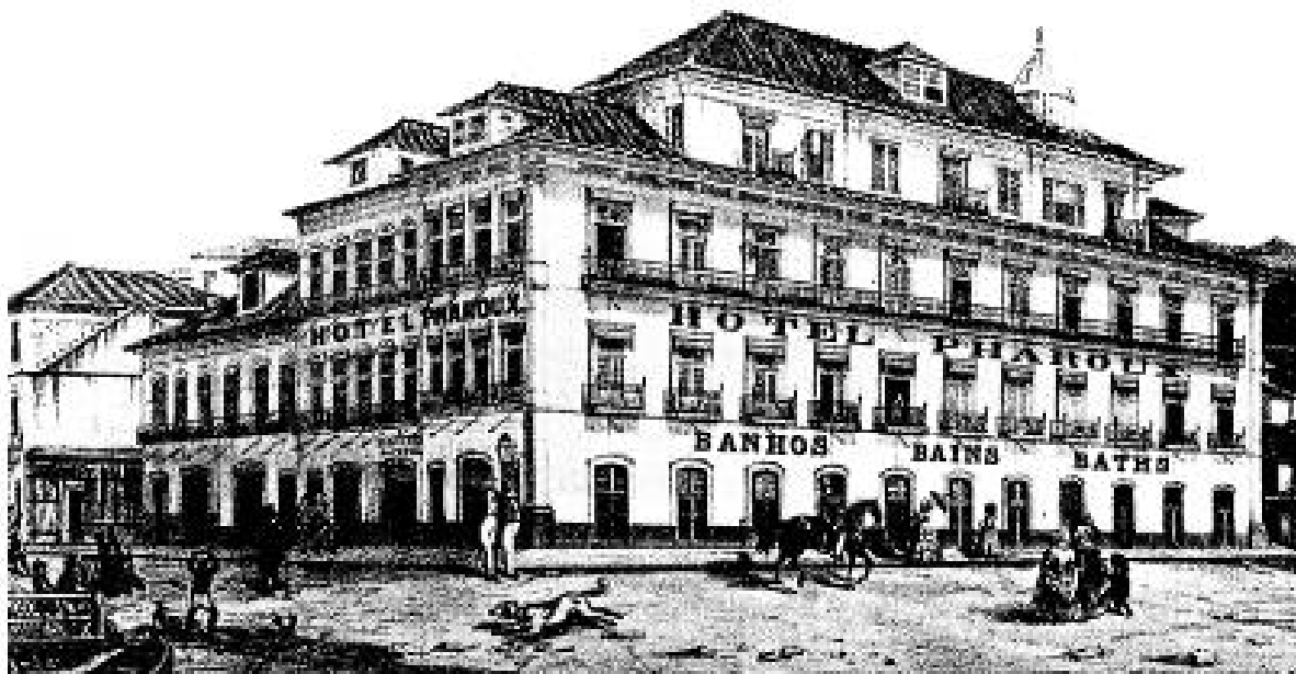
Figura 17 – Vista externa do Hotel Pharoux, Rio de Janeiro.
