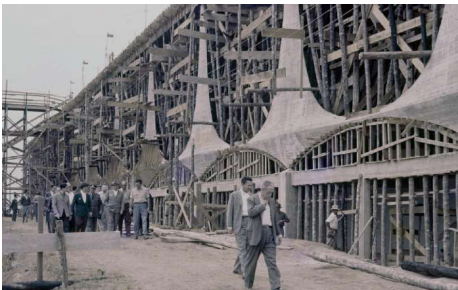
Figura 64 - O Palácio da Alvorada em construção.1957.
