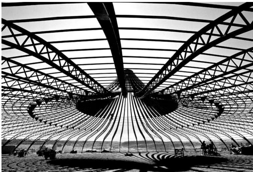
Figura 89 e 90 - Componentes em aço nas obras de Lelé .
