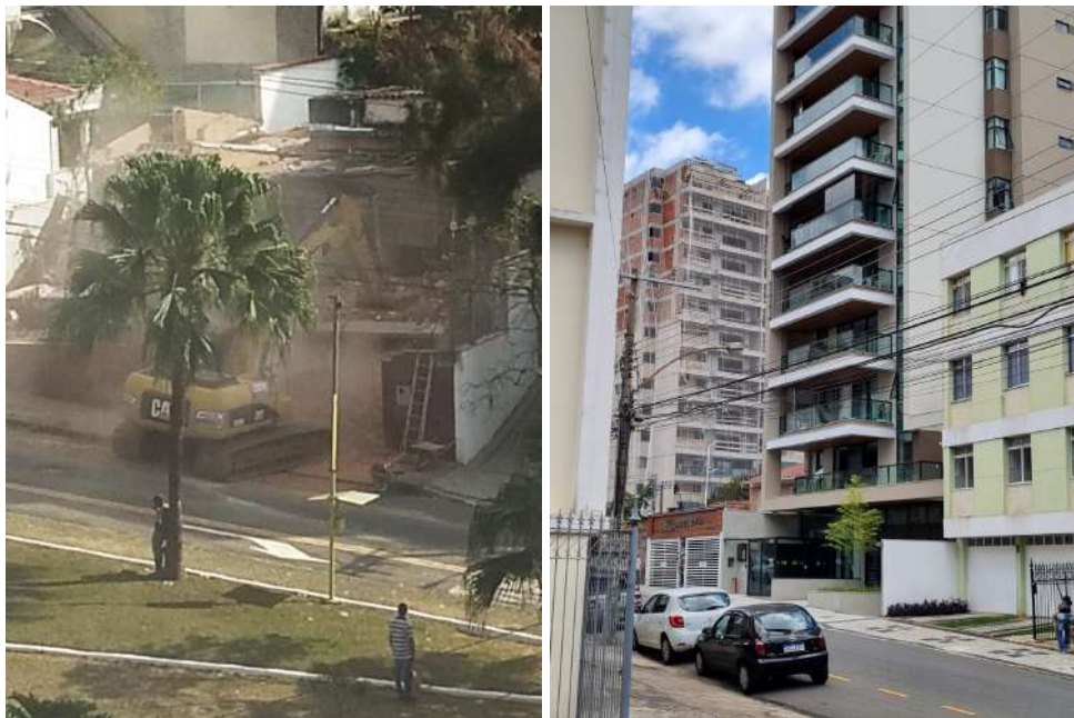
Figuras 96 e 97 - Demolições e verticalização no bairro Santa Helena (divisa com bairro Centro)
