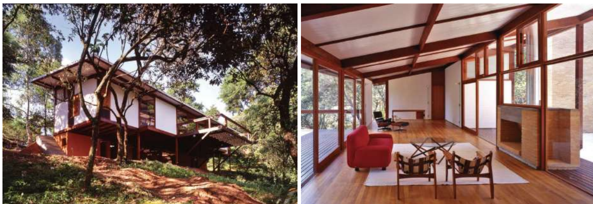
Figuras 74 e 75 - UNA Arquitetos / Residência OOV / Carapicuíba, Brasil (1999)
