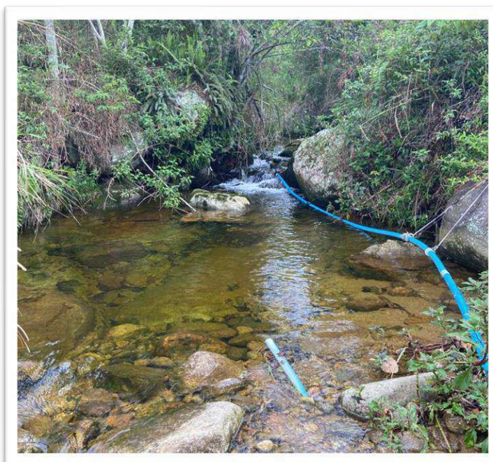
Figura 71 – Captação de água no rio Itamarati
