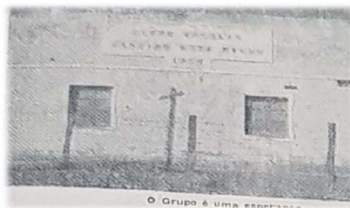
Figura 16 – Escola Estadual Professor Cândido Motta Filho, 1971. Na época, situada na esquina da Av. Agilberto Costa com José Zacarias
