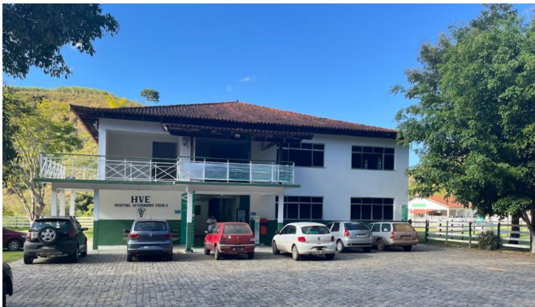
Figura 37 - Fachada do HVE-A
