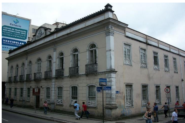
Figura 18: Fachadas do Palacete Santa Mafalda – Antes da restauração, 2020.
