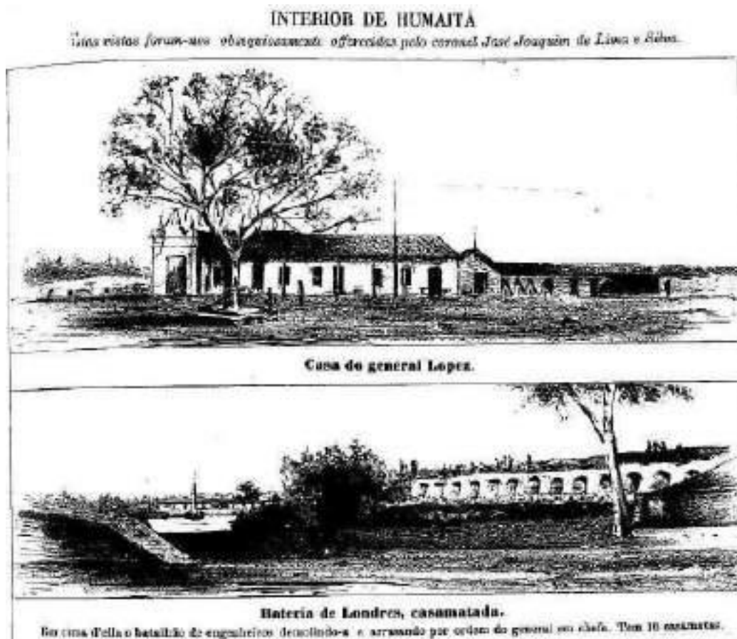
Figura 233: Interior de Humaitá. Estas vistas foram-nos obsequiosamente oferecidas pelo coronel José Joaquim da Lima e Silva. Casa do general Lopez. Bateria de Londres, casamatada. Em cima dela, o batalhão de engenheiros demolindo-a e arrasando por ordem do general em chefe. Tem 15 casamatas. Semana Illustrada , 13 de setembro de 1868, n. 405.
