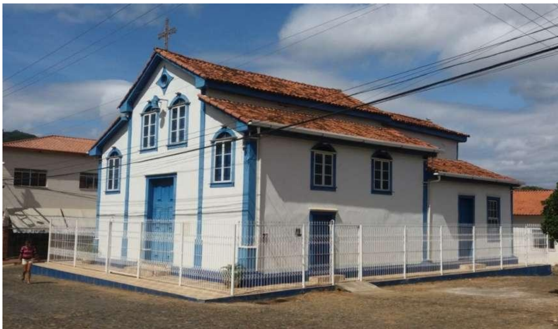
Figura 24: Igreja de Nossa Senhora do Rosário. Vista da fachada frontal e lateral direita. Descoberto/MG. Foto: Elza Vieira - Julho/2023.
