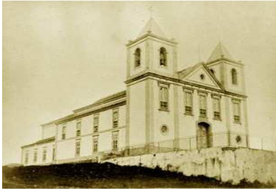
Figura 47: Antiga Igreja Matriz de São João Nepomuceno construída em 1840. Vista da fachada frontal e lateral esquerda. São João Nepomuceno/MG. Data: 1905. Autor: s/r. Fonte: Prefeitura Municipal de São João Nepomuceno.
