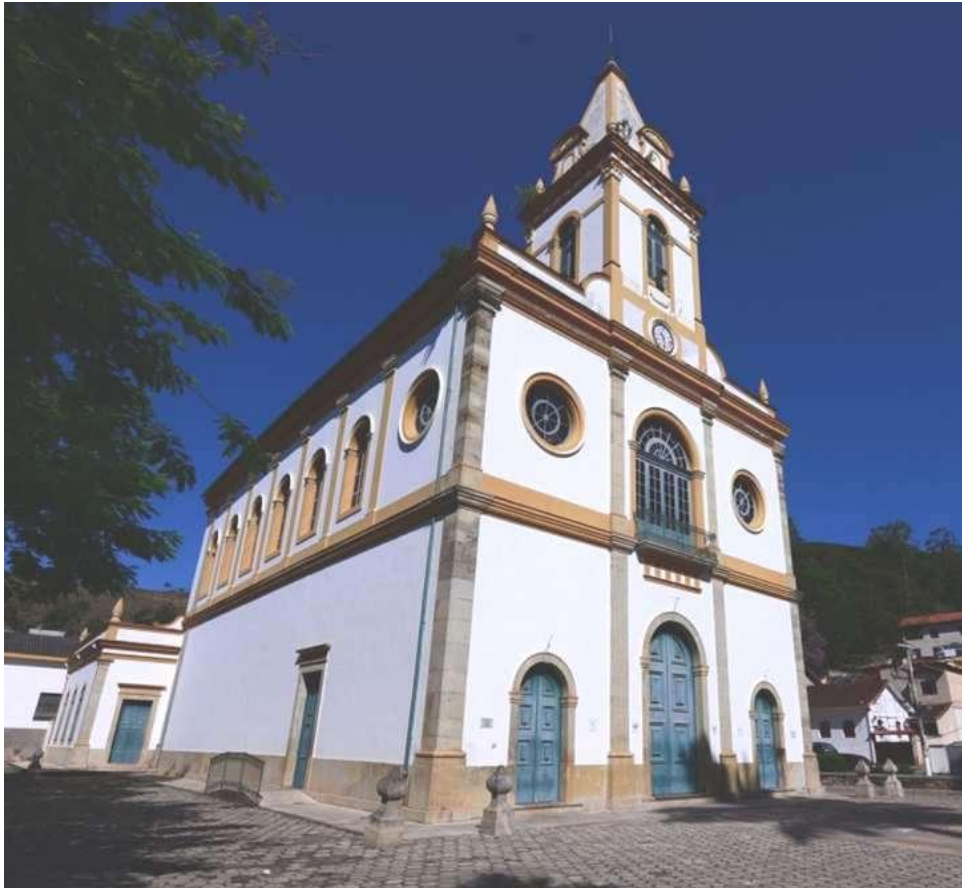
Figura 96: Vista da fachada frontal da Igreja Matriz de Nossa Senhora das Mercês, construída em 1886. Eclética/Neoclássica. Mar de Espanha/MG. Foto: Elza Vieira – Setembro/2023.
