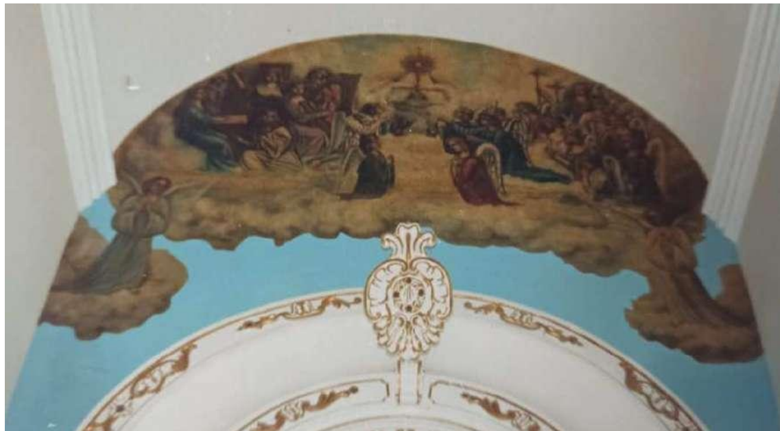
Figura 88: Igreja Matriz de São Manoel. Vista do interior. Pintura sobre o retábulo-mor executada por Antônio Porfírio. Fonte: IPAC/2010 – Secretaria de Cultura de Turismo. Rio Pomba/MG.
