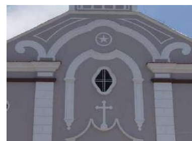
Figura 81: Igreja Matriz de São Manoel. Foto fachada frontal – detalhe central: óculo. Rio Pomba/MG. Foto: Elza Vieira - Dezembro/2023.
