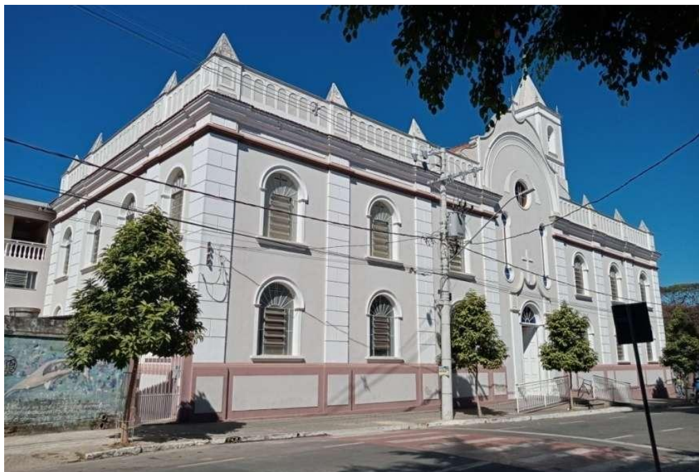
Figura 77: Igreja Matriz de São Manoel. Vista da fachada lateral esquerda e posterior. Rio Pomba/MG. Foto: Elza Vieira – Novembro/2023.
