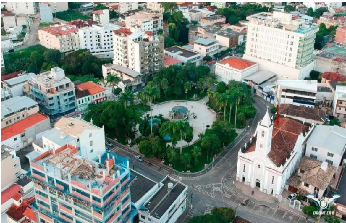
Figura 03: Vista parcial do centro da cidade de Rio Pomba em 2018. Temos a Igreja Matriz de São Manoel à direita da Praça Dr. Último de Carvalho. Percebe-se a descaracterização arquitetônica das antigas edificações.
