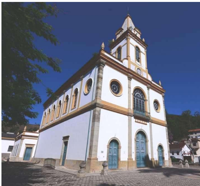
Figura 96: Vista da fachada frontal da igreja Matriz de Nossa Senhora das Mercês, construída em 1886. Eclética/Neoclássica. Mar de Espanha/MG. Foto: Elza Vieira – Setembro/2023.
