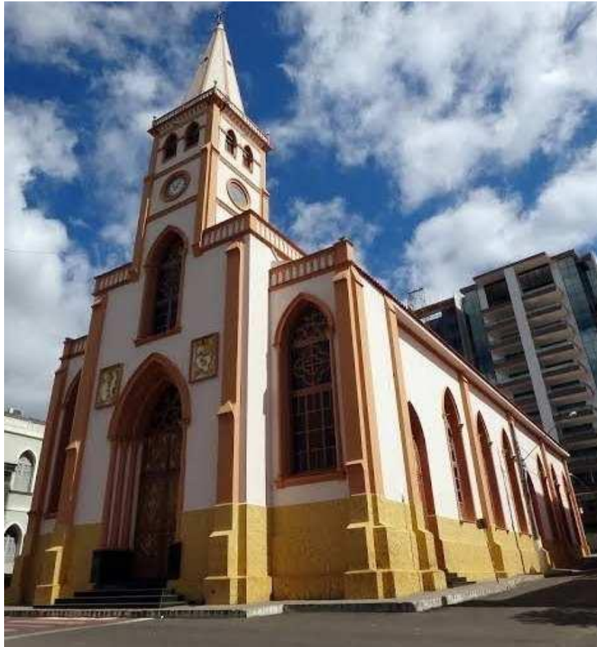
Figura 100: Vista da fachada frontal da Igreja Matriz de São João Batista, construída entre 1907 – 1917. Eclética/Neogótica. Visconde do Rio Branco/MG. Foto: Elza Vieira – Agosto/2023.
