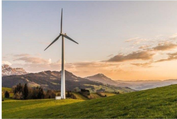
Figura 52 - Unidade eólica onde pode ser visto a turbina (hélice) e o gerador.
