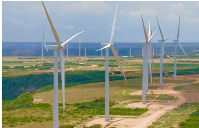
Figura 53 - Parque eólico onshore
