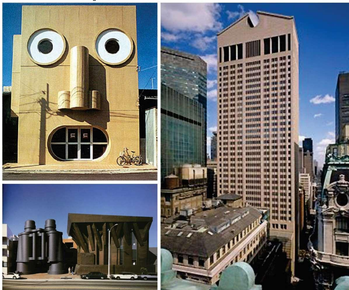
Figura 01 – Edifícios de tendência Pós-Moderna 3 .
