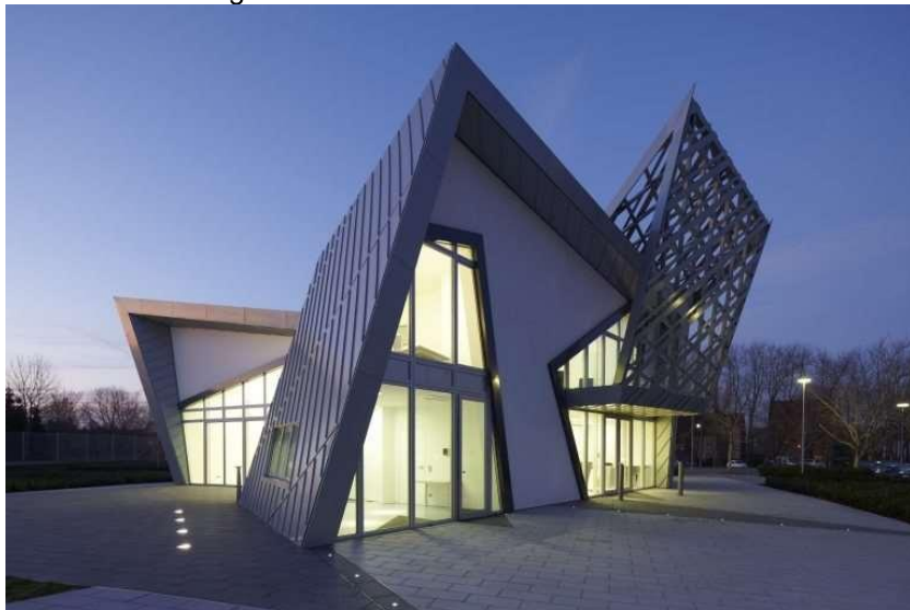
Figura 58 – Fachada da Villa Libeskind .
