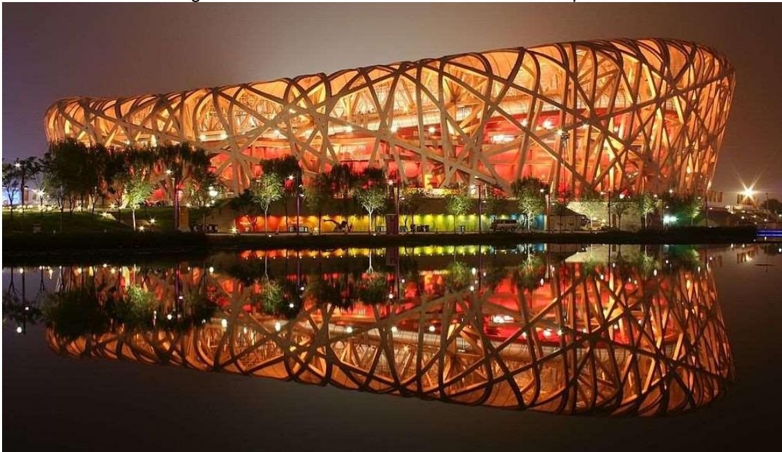
Figura 65 – Fachada do Estádio Nacional de Pequim .
