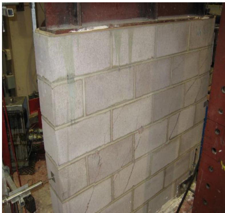
Figura 18 - Exemplo de trincas em paredes com carregamento unidirecional
