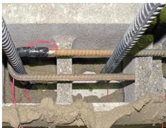
(c) Dobra de 180° envolvendo a armadura vertical
