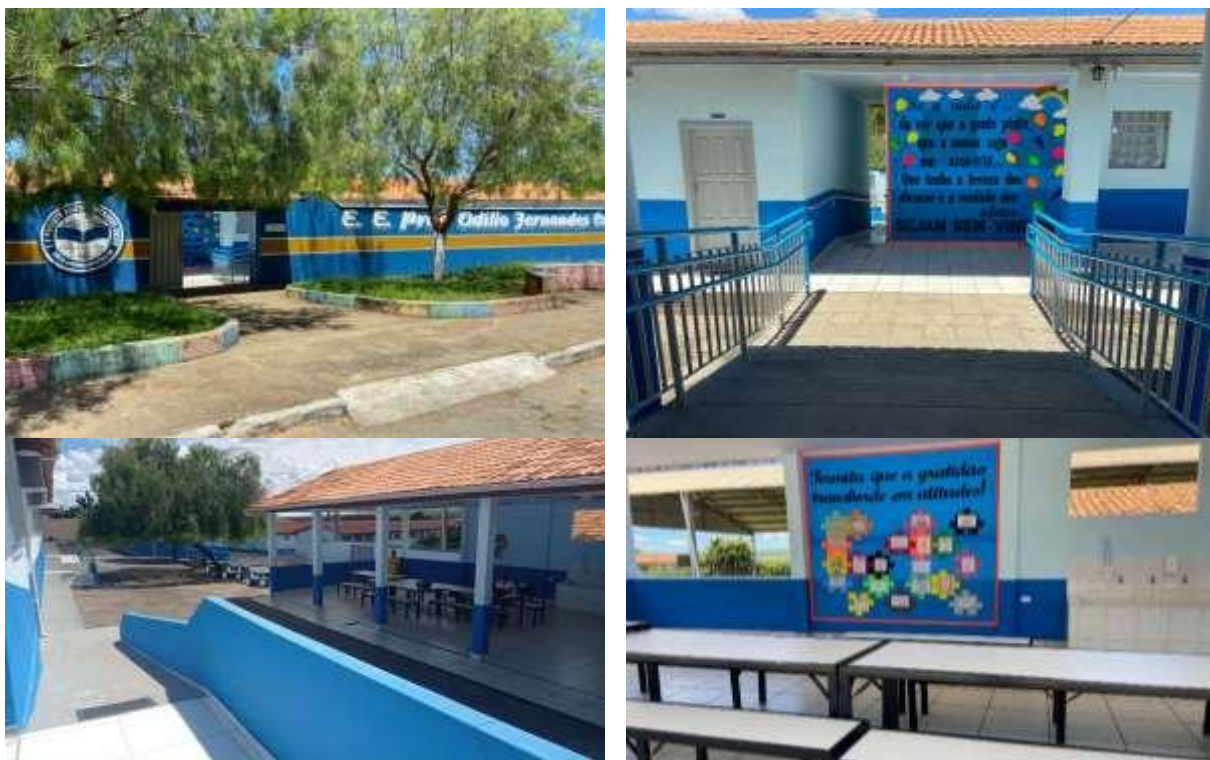
Figura 4 - Visão geral da EEPOFC sede
