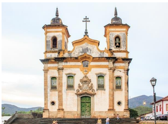
FIGURA 43. Igreja São Francisco de Assis, Ouro Preto, Minas Gerais. Fonte: https://upload.wikimedia.org/wikipedia/commons/6/69/Igreja_de_S%C3%A3o_Francisco_de_Assis_%28Ouro_Preto%2C_MG%29_por_Rodrigo_Tetsuo_Argenton.jpg - Acesso em 21/12/2022.
