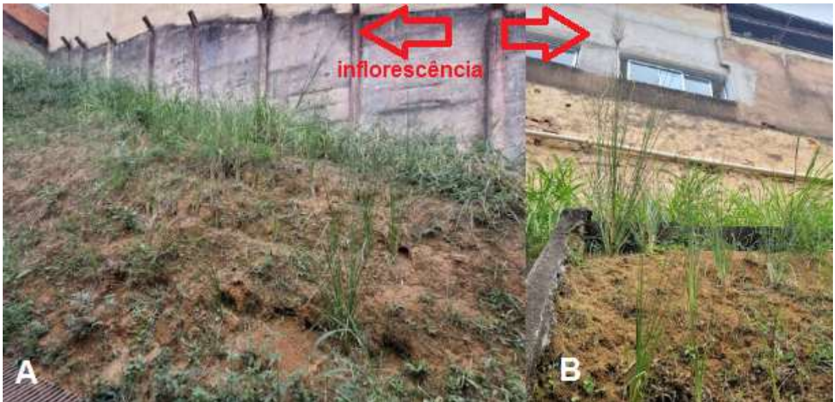
Figura 37 - Desenvolvimento do capim Vetiver após um ano de plantio no talude de estudo
