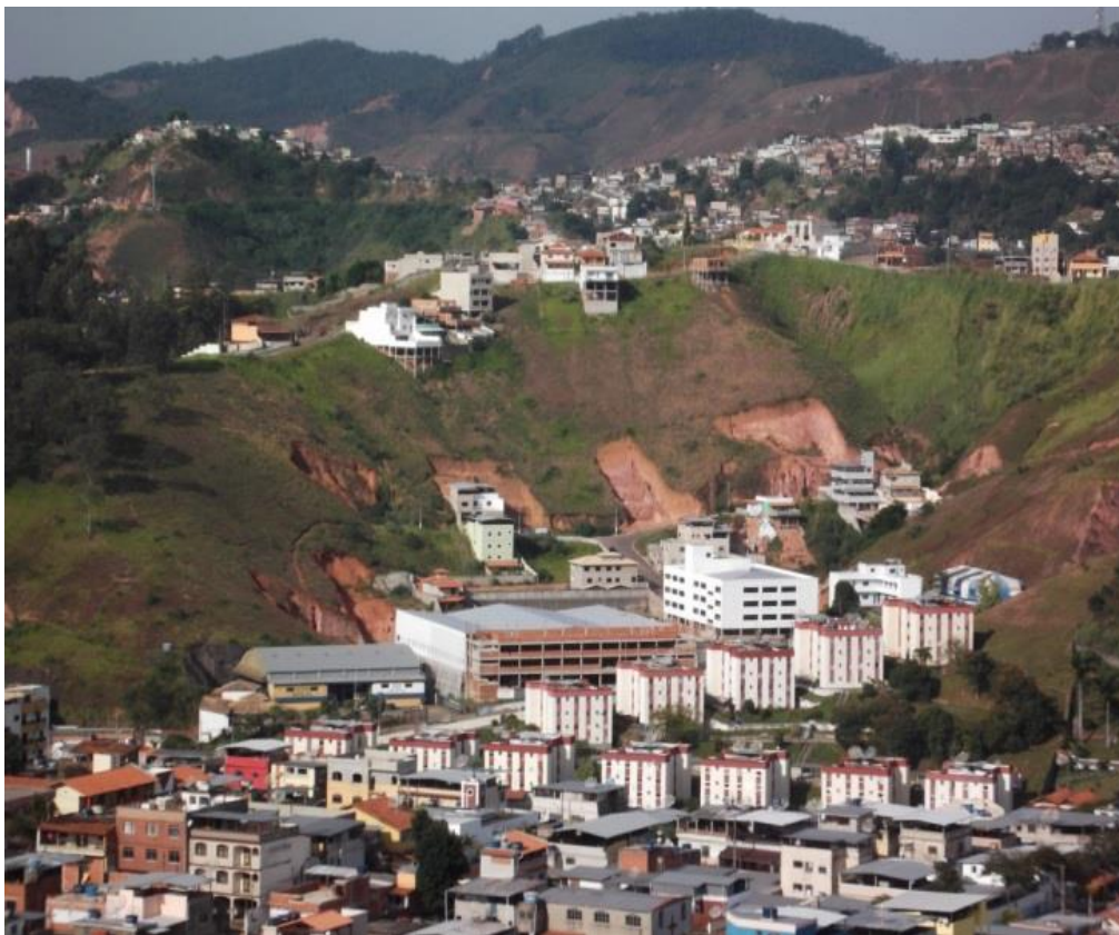
Figura 147: Cortes de terreno e pontos de escorregamentos no bairro Quintas da Avenida. Fonte: do autor, 2015.
