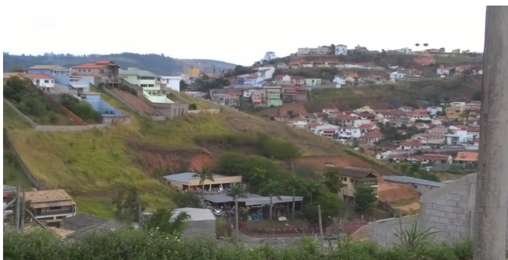
Figura 18: Escorregamento na subida da serra do Bairro Bandeirantes, em área de morro.
