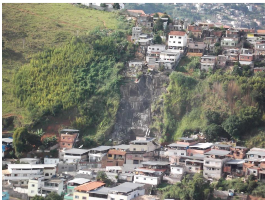
Figura 33: Dois pontos de escorregamentos no bairro Eldorado em área de relevo declivoso. Fonte: do autor, 2015.
