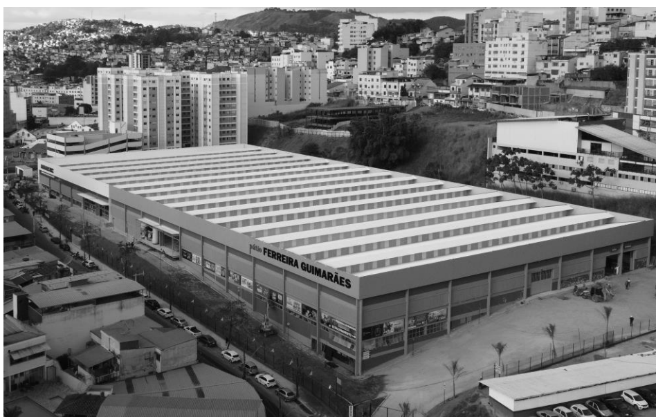
Figura 40: Edifício da antiga Central de Acabamento da Companhia Têxtil Ferreira Guimarães, atualmente a edificação é um centro comercial
