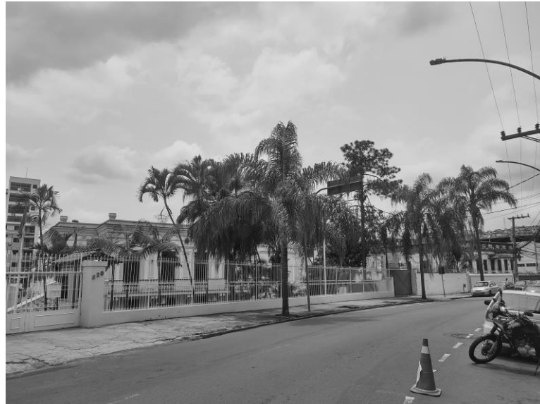
Figura 29: Edifício tombado sede da 4ª Circunscrição Judiciária Militar de Minas Gerais
