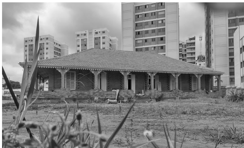
Figura 39: Casa dos Hóspedes, localizada na Rua Benjamin Guimarães
