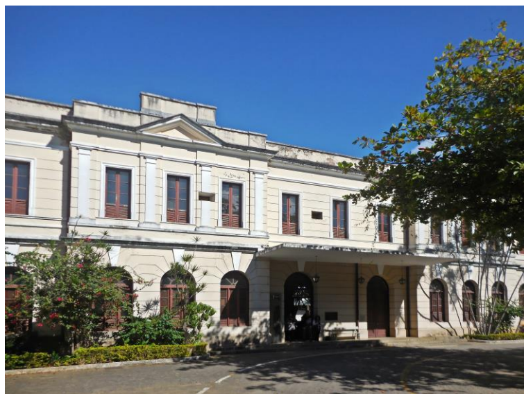
Figura 24: Edifício da Estação Leopoldina atualmente
