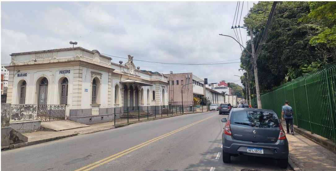
Figura 21: Edifício da Estação Mariano Procópio atualmente
