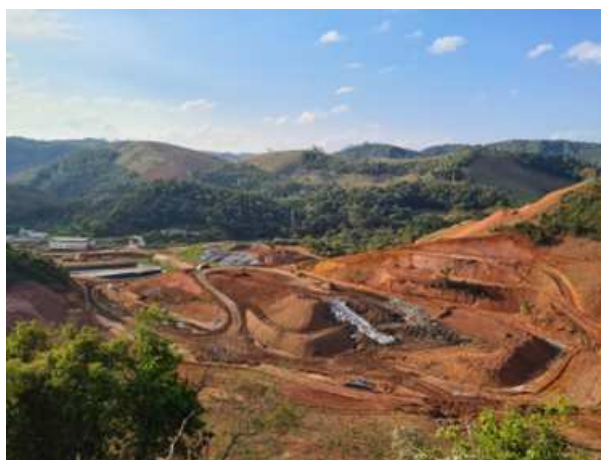
Figura 4 – Vista do Aterro Classe II da Essencis MG - UVS Juiz de Fora, local para destinação de resíduos não perigosos
