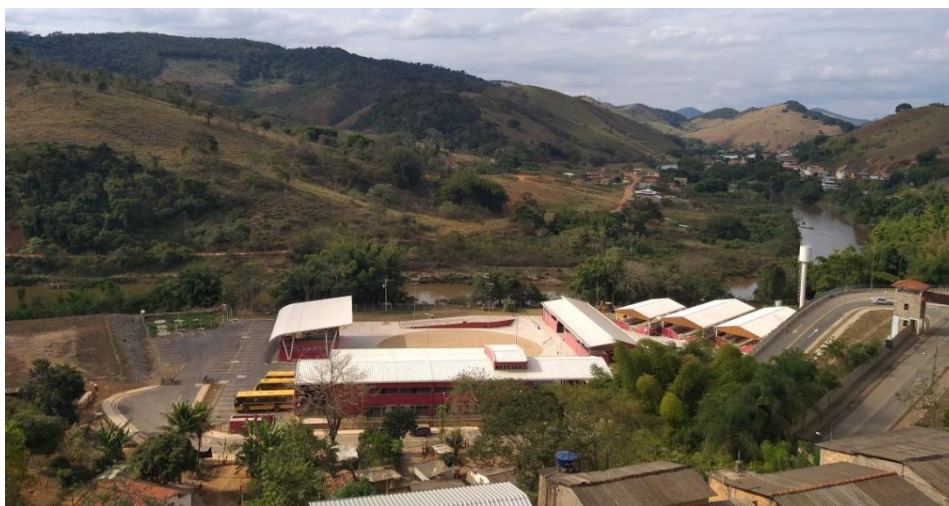
Figura 11 – Parque de exposições reformado no bairro Volta da Capela
