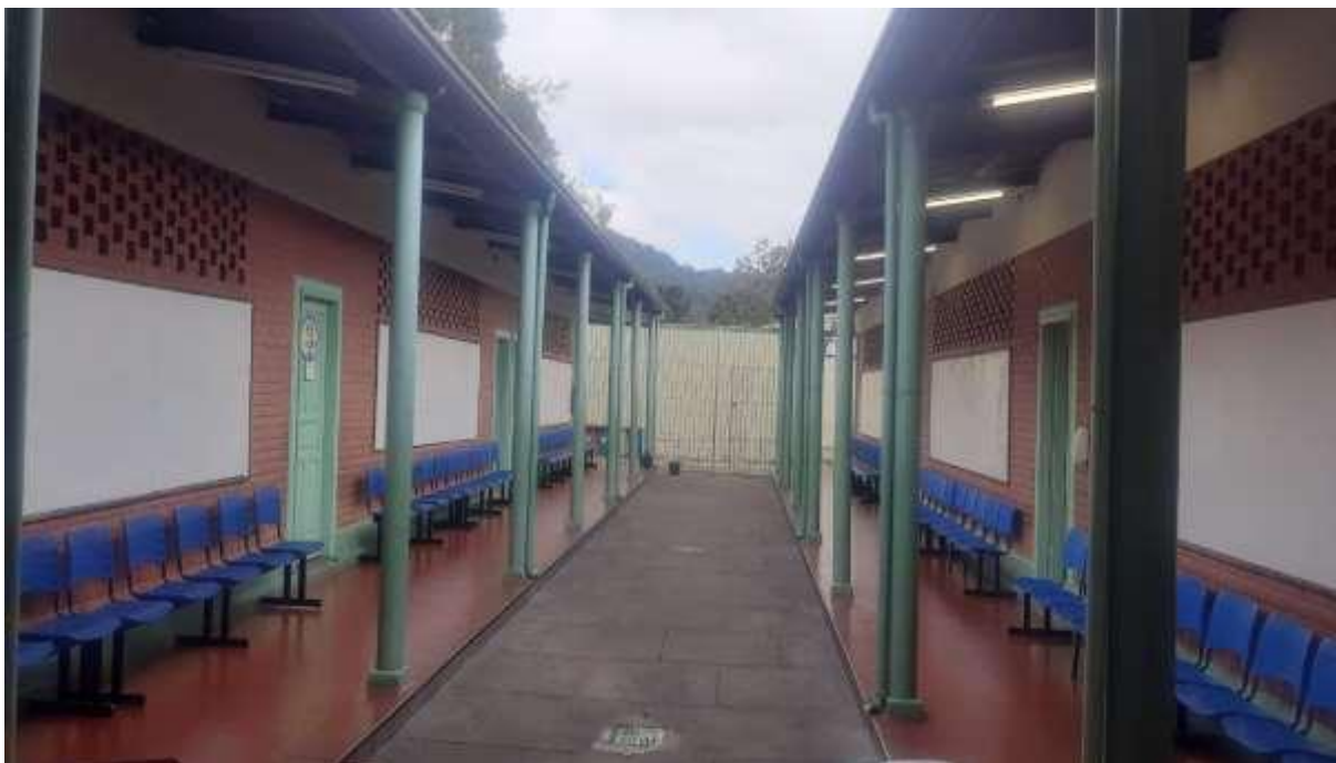
Figura 2 - Visão parcial do interior do prédio da E. E. Professor José Eutrópio
