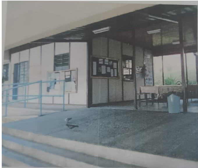
Figura 14 – Parte interna da escola
