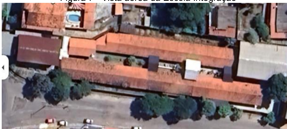
Figura 7 - Vista aérea da Escola Integração
