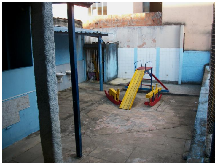
Figura 9 – Foto do Parquinho – Neste ângulo podemos perceber que há um declive no terreno, portanto a posição da qual a foto é registrada é uma escada
