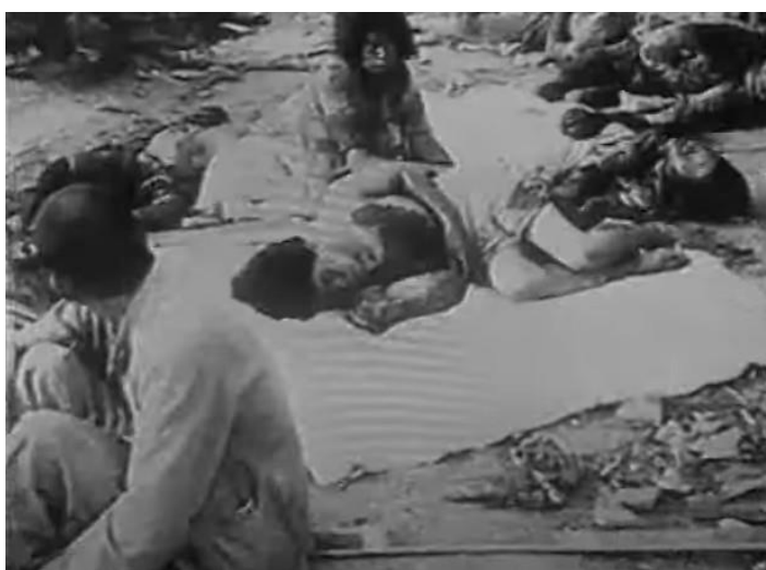
Figura 31 - Destruição causada pela bomba atômica em 1945
