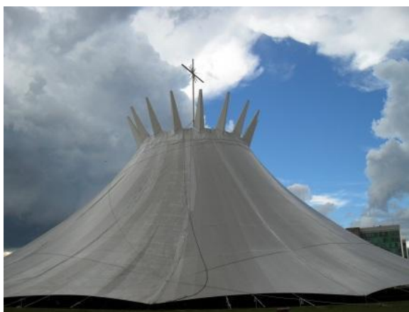
Figura B1 – Cobertura provisória de lona (Imagem cedida pela FRF).
