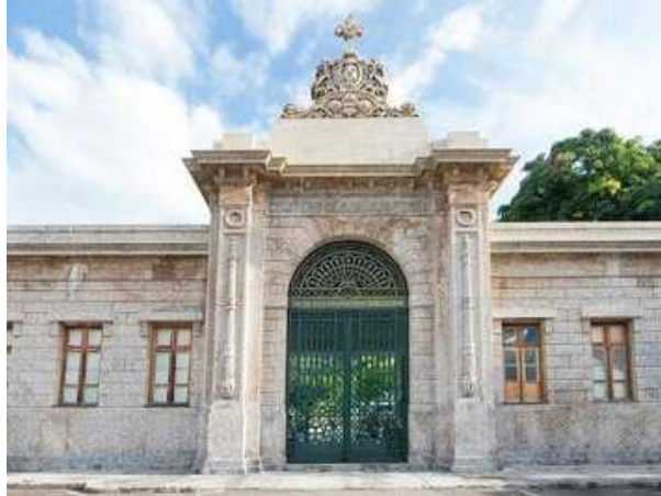
Figura 4 – Vista da entrada do Cemitério São João Batista, Rio de Janeiro.
