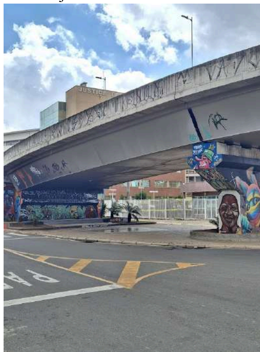
Figura 23: vão do Vd. Arquiteto Hélio Fadel Araújo.
