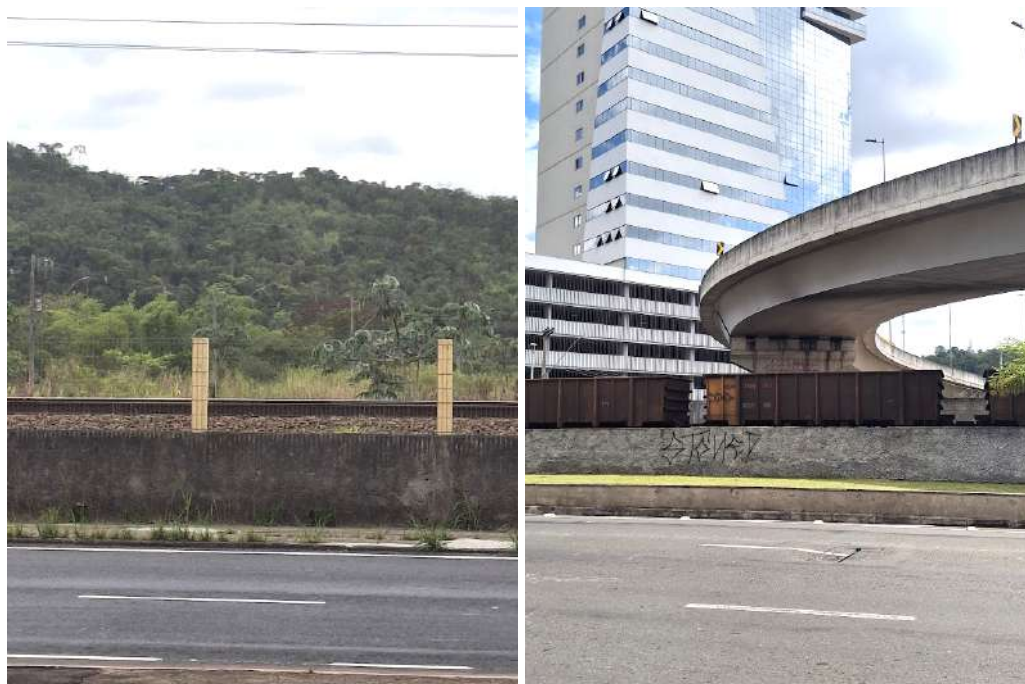
Figura 16: estratégias de vedação da ferrovia na área urbana de Juiz de Fora (MG)
