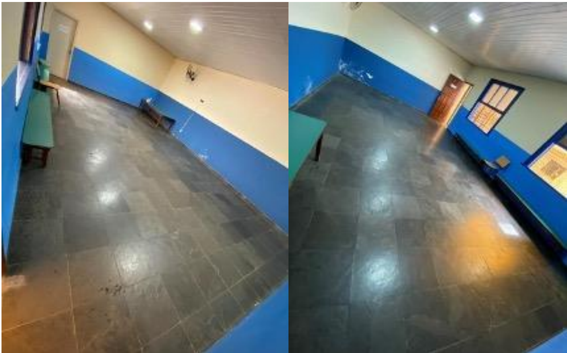
Figura 7 – Terraço – Sala de aula de Educação Física
